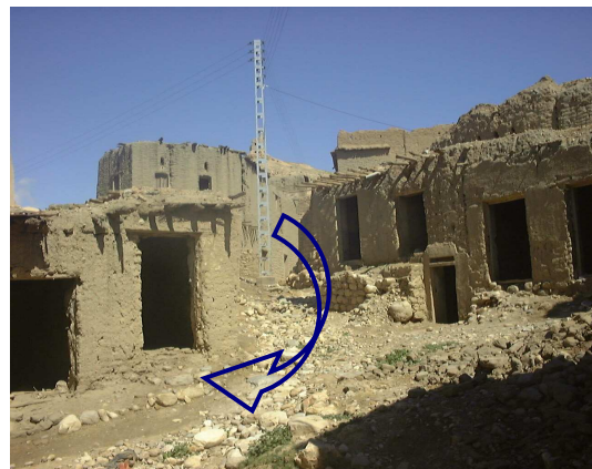
Photo. 39 : la forme de terrain accentue l'effet de pluie et son action destructrice
