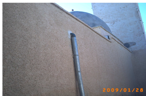
Photo. 47 : La canalisation pour les eaux pluviales
