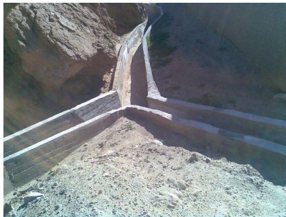
Photo 53. 54 : les digues en béton armé pour la canalisation des eaux de ruissellement
