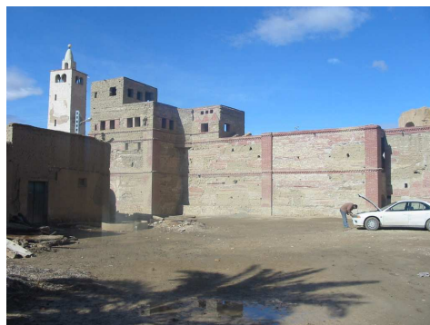
Photo 27 : Transformation de la Sraya après sa restauration
