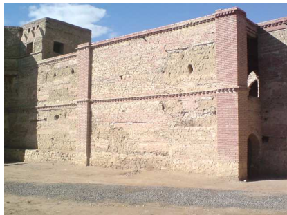
La Sraya vue de l'extérieur
