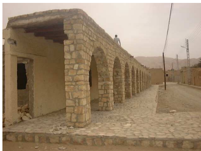
Photo. 23 : les logements évolutifs après modifications sur la façade Source : Auteur 2007
