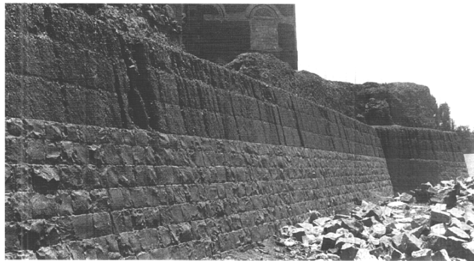
Photo. 14 : une partie de la muraille, une semaine après la réfection de la partie supérieure en Zabour
