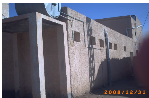
Photo.45 : la salle des ablutions après achèvement des travaux
