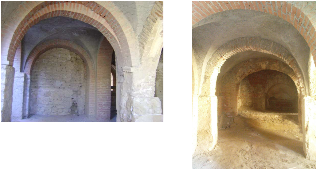
Photo 72.73 : l'utilisation des nouveaux matériaux pour la restauration des voûtes
