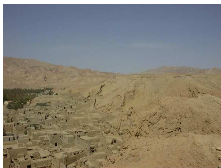
Photo. 17 : Le Coté Est de la Dachra qui épouse la forme de la montagne
