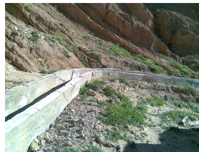
Photo 53. 54 : les digues en béton armé pour la canalisation des eaux de ruissellement
