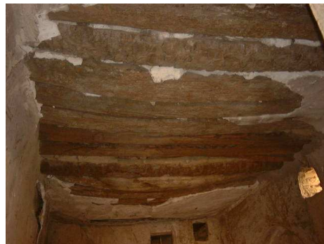
Photos. 60 et 61 : exemple de plancher dégradé (à gauche) et moyen (à droite)
