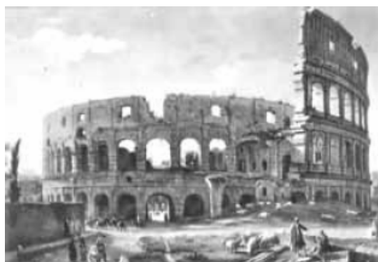
Fig. 07 : Le Colisée. Peint par Gaspar Van Wittel qui montre la structure avant les restaurations du dix-neuvième siècle
