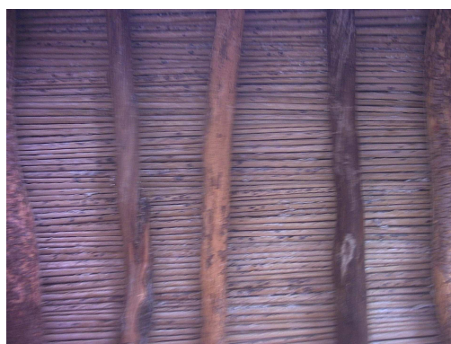
Photo. 34 : une toiture constituée par des poutres de palmier prenant appui à leurs extrémités Source : Auteur. 2007
