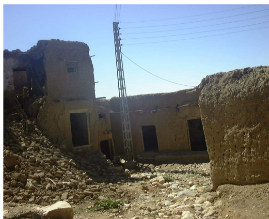
Photo. 37 : l'implantation des poteaux électriques à l'intérieur du tissu traditionnel interrompt la continuité visuelle et l'harmonie du site
