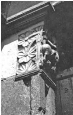
Photo.05 : La Madeleine, un nouveau chapiteau qui remplace le vieux dans la façade Ouest,
