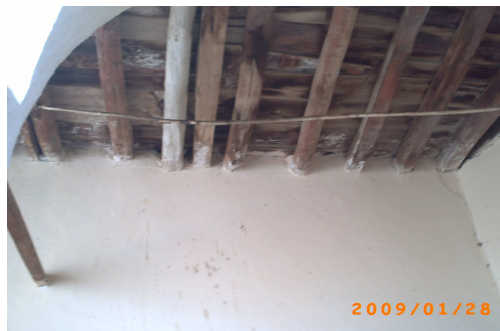
Photo. 46 : une toiture rénovée faite en chevrons, planches et argile
