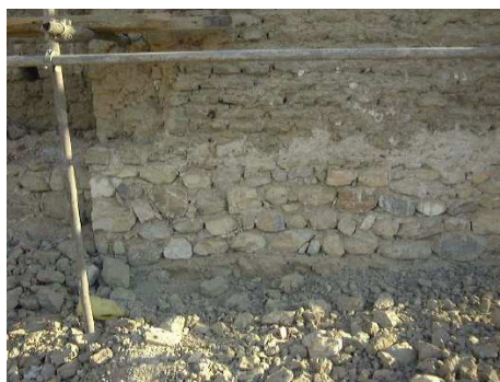
Photo. 32 le soubassement des murs réalisé en pierres naturelles
