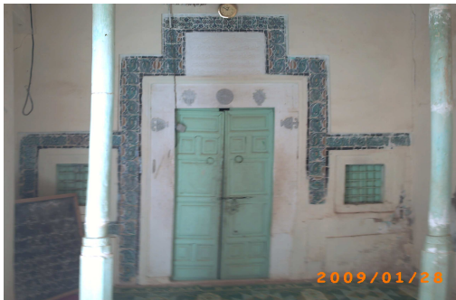
Photo. 50 : La porte du mausolée réparée
