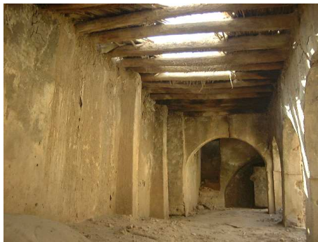
Photos. 60 et 61 : exemple de plancher dégradé (à gauche) et moyen (à droite)
