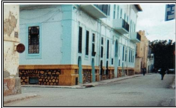
Figure 6-4 : APC, la façade postérieure où donnent la plupart des bureaux
