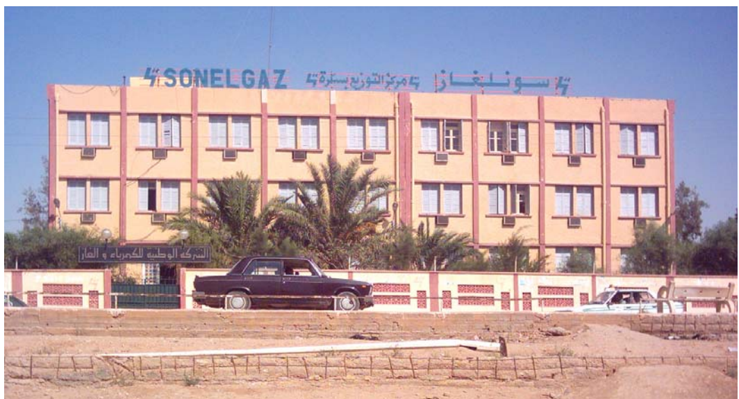
Figure 5-7 : Un bâtiment de bureaux bâti pendant l'ère de l'économie socialiste à Biskra avec une façade principale orientée ouest, "Centre de Distribution de L'électricité"
