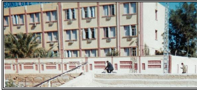
Figure 6-16 : Bâtiment de la "sonelgaz", vue de l'extérieur
