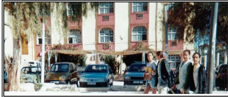
Figure 6-9 : Bâtiment de la direction de la jeunesse et du sport "DJS", vue sur la façade sud
