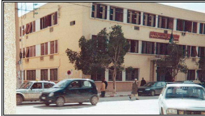
Figure 6-6 : Bâtiment des "impôts", vue extérieure
