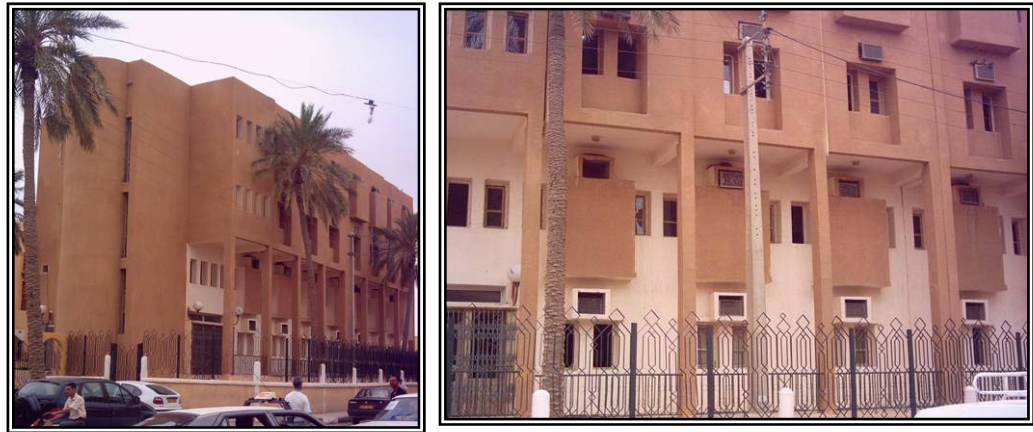
Figure 6-29 : DRAG, Vue extérieure et détail de la façade ouest
