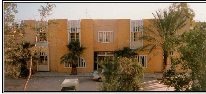
Figure 6-31 : Bâtiment de la direction des équipements "DLEP", la façade
