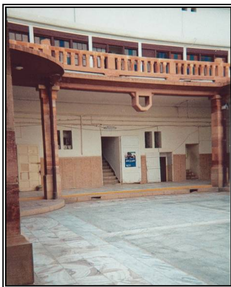
Figure 6-2 : Bâtiment de la mairie de Biskra "APC", vue sur le patio
