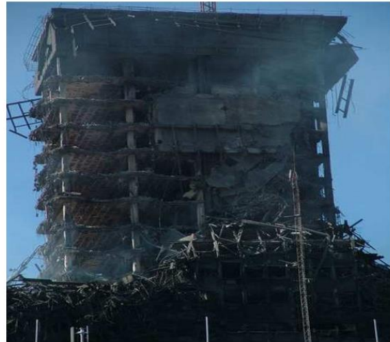
Tour Windsor (Madrid) 2005, Partie de la structure en béton, [Debu, 2005].39
