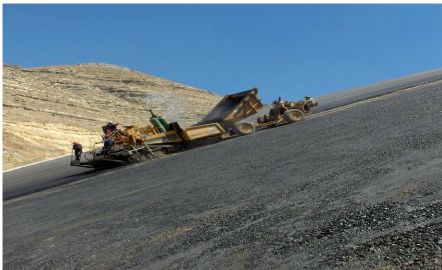
Fig. III.22 : Dumper alimentant le finisseur ( www.cea-coop.it/...pdf/CEA_SARTI_CATALOGO_ENG ).
