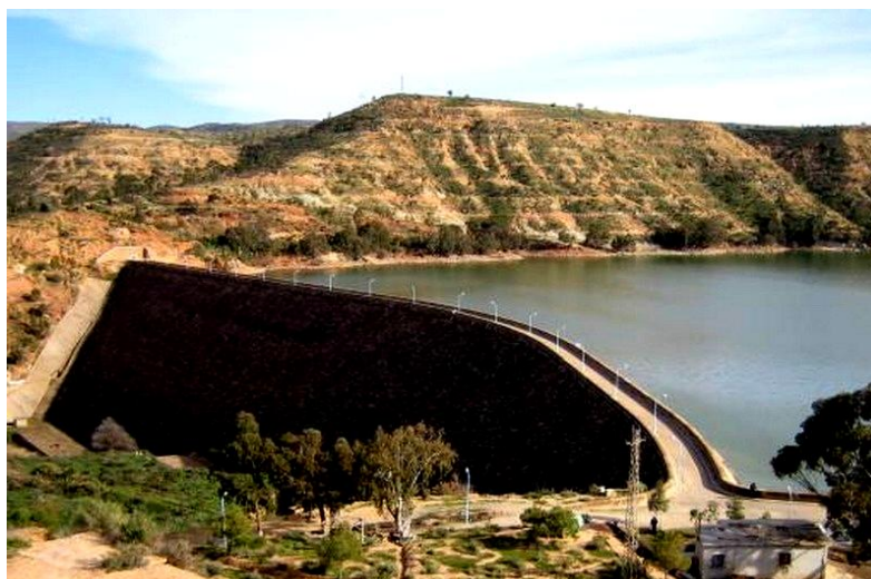
Fig. III.11 : Le barrage de Bouhnifia , Mascara ( http://encyclopedie-afn.org/Barrage_-_Bouhnifia ).
