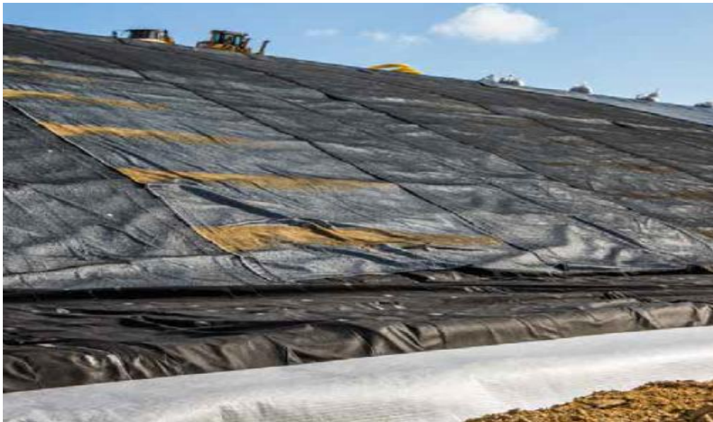
Fig. II.10: Mise en place d'une géomembrane bitumeuse ( http://www.cfg.asso.fr/les-membres/presentation/activite/3 ).
