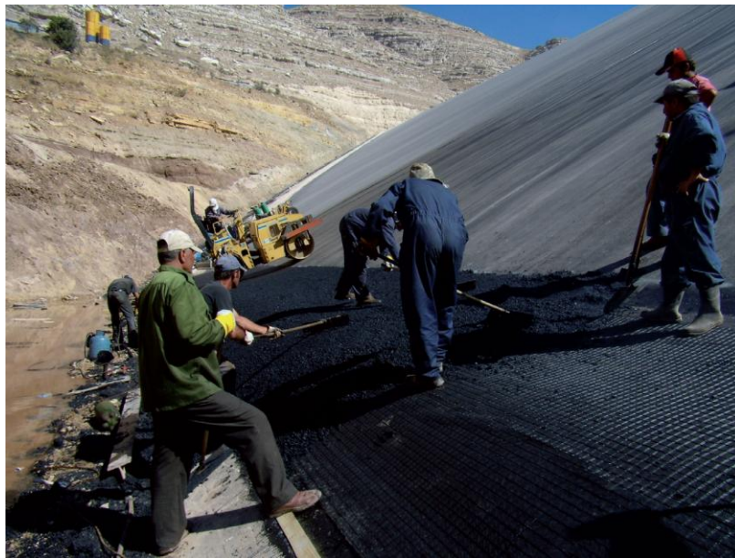
Fig.III.25 : Application de géo-grille et compactage en suite( www.cea-coop.it/...pdf/CEA_SARTI_CATALOGO_ENG ).
