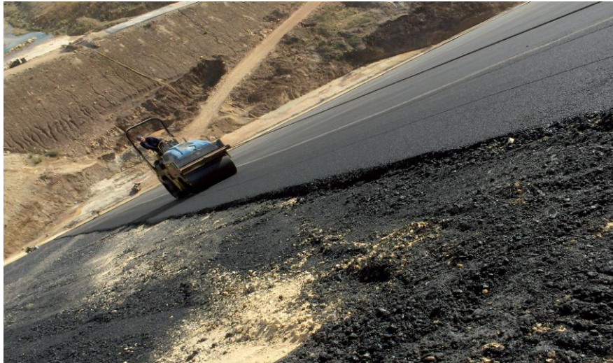
Fig. III.23 : Compactage primaire par un rouleau vibrant à 2,5 tonnes ( www.cea-coop.it/...pdf/CEA_SARTI_CATALOGO_ENG ).
