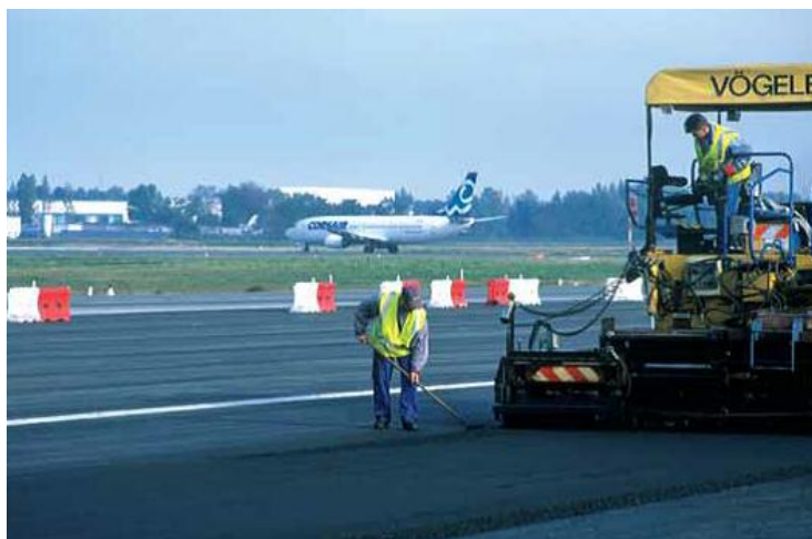
Fig. I.11 : Travaux routier ( Bitume Québec, 2008 ).
