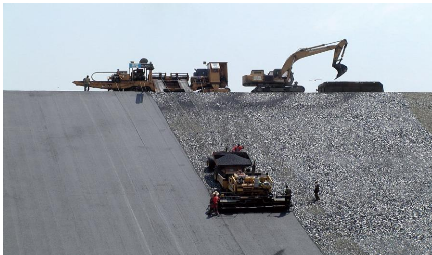
Fig. III.19: Le treuil principal camion sécurise le module de finition, le dumper et le rouleau ( www.cea-coop.it/...pdf/CEA_SARTI_CATALOGO_ENG ).
