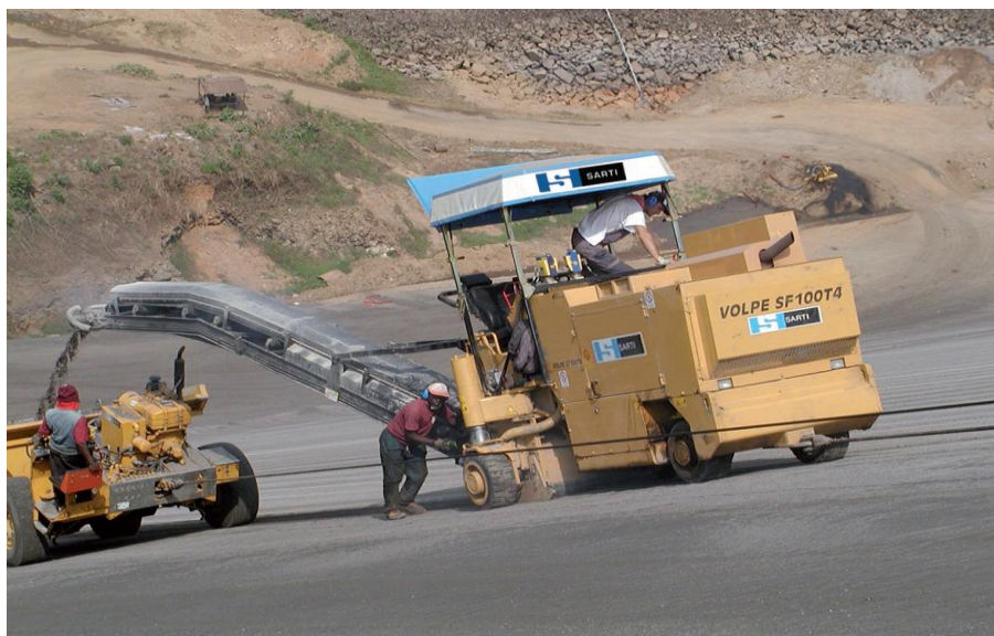
Fig. III.26: Fraisage du revêtement endommagé ( www.cea-coop.it/...pdf/CEA_SARTI_CATALOGO_ENG ).
