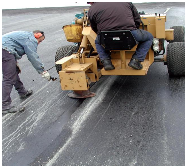
Fig.III.24: Chauffage et re-compactage d'une couche ( www.cea-coop.it/...pdf/CEA_SARTI_CATALOGO_ENG ).
