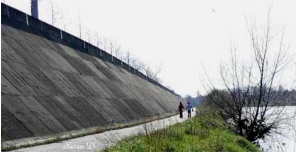
Fig. I.16: Protection des berges par le béton bitumineux ( http://septdeniersweb.free.fr/son%20histoire/berge_01.htm )
