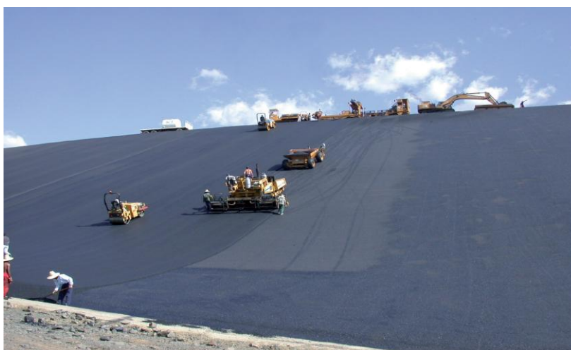
Fig.III.18: Vue globale des machines opérant lors revêtement ( www.cea-coop.it/...pdf/CEA_SARTI_CATALOGO_ENG ).
