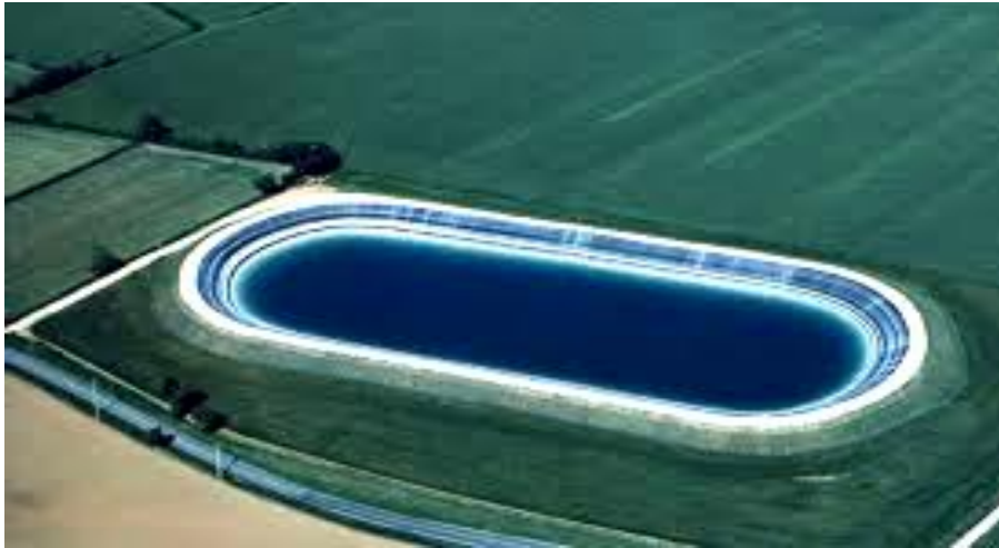
Fig. I.14 : Protection d'un bassin par géomembrane bitumineuse ( http://www.soprema.fr/fr/article/dossier-thematique/l-etancheite-des-ouvrages-hydrauliques ).
