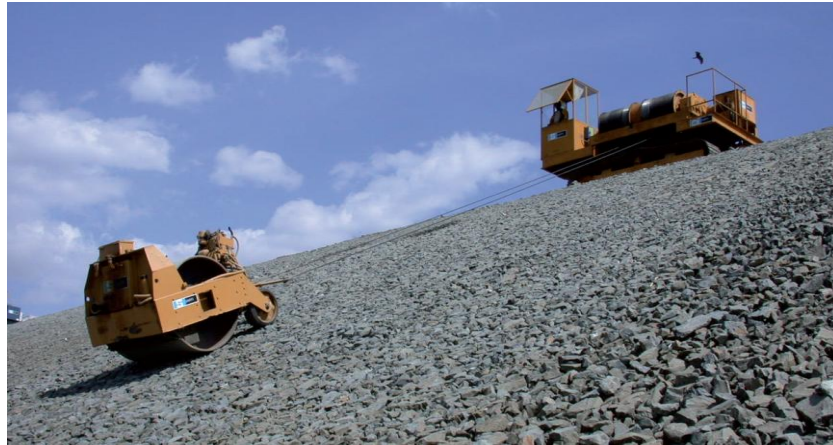
Fig.III.20 : Laminage préliminaire de la couche de base ( www.cea-coop.it/...pdf/CEA_SARTI_CATALOGO_ENG ).
