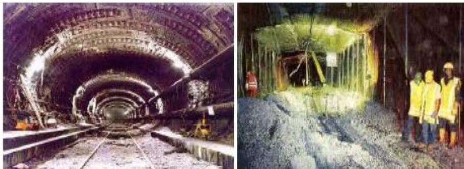
Figure I.24 Écaillage du tunnel sous la Manche et tunnel de Tauern [Mindeguia,2009]
