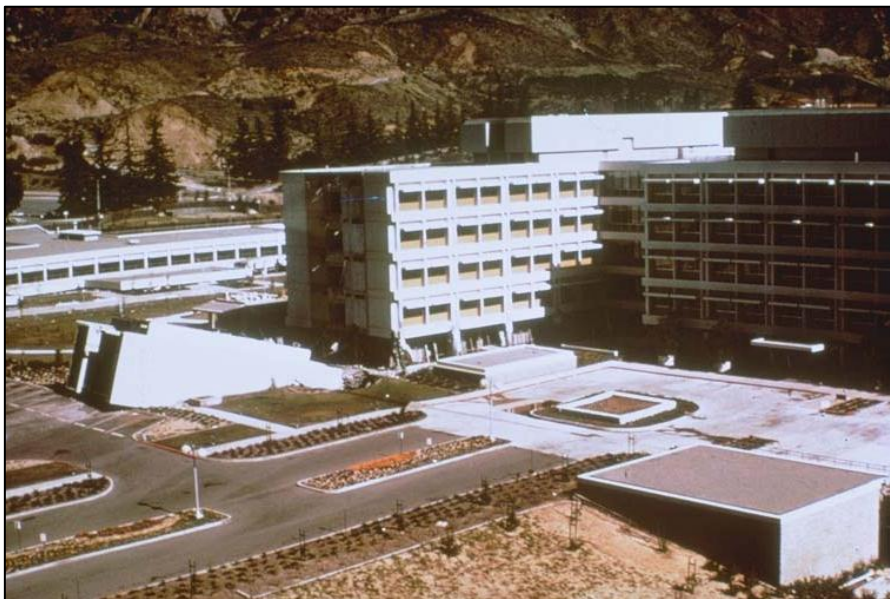
Figure 1.2 : La tour de l'hôpital effondrée à cause de l'insuffisance du joint de séparation qui causé un entrechoquement entre la tour et le bloc qui l'avoisine séisme de San Fernando 1971 [5]
