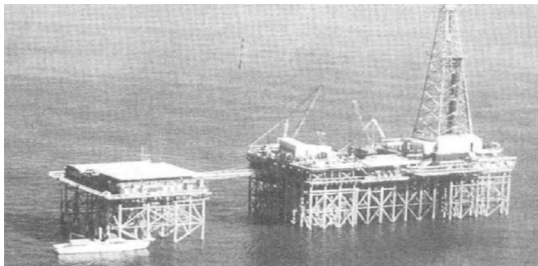
Figure 1.1 Première installation offshore « Superior » en 1947, à Louisiana (Leffler et al. 2003)
