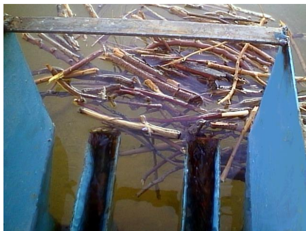
Figure 1.14. Fonctionnement du P.K. Weir avec encombrement de l'entrée par des corps flottants.
