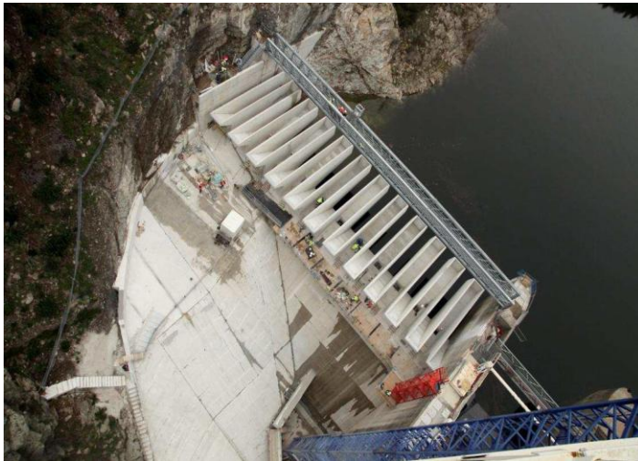
Figure 1.7. Déversoir en touches de piano (PK-Weir) réalisé en 2012 au Barrage de Malarce (France).
