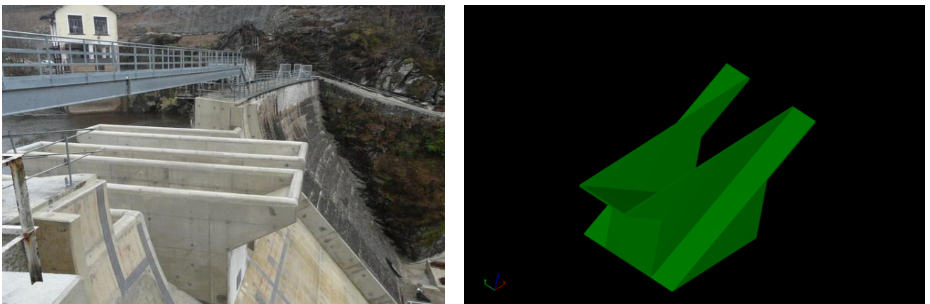
Figure 1.6. Déversoir en touches de piano (PK-Weir)
