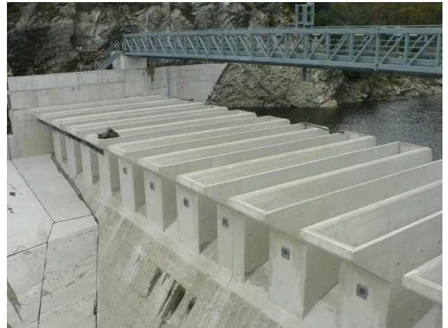
Figure 1.7. Déversoir en touches de piano (PK-Weir) réalisé en 2012 au Barrage de Malarce (France).
