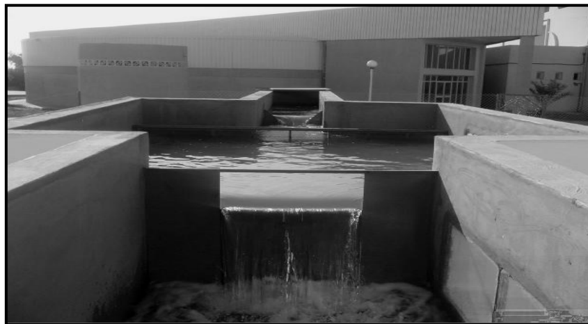
Figure 3.2. Vue de l'aval de la station d'expérimentation des modèles réduits
