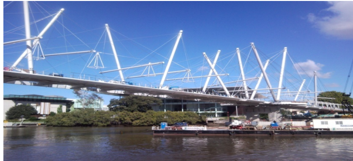
Fig 1.16 Kurilpa Bridge à Brisbane en Australie
