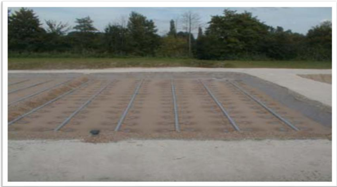
Figure 3.11 : Photo. . Répartition par tuyau horizontal. (DADDH, 2012)
