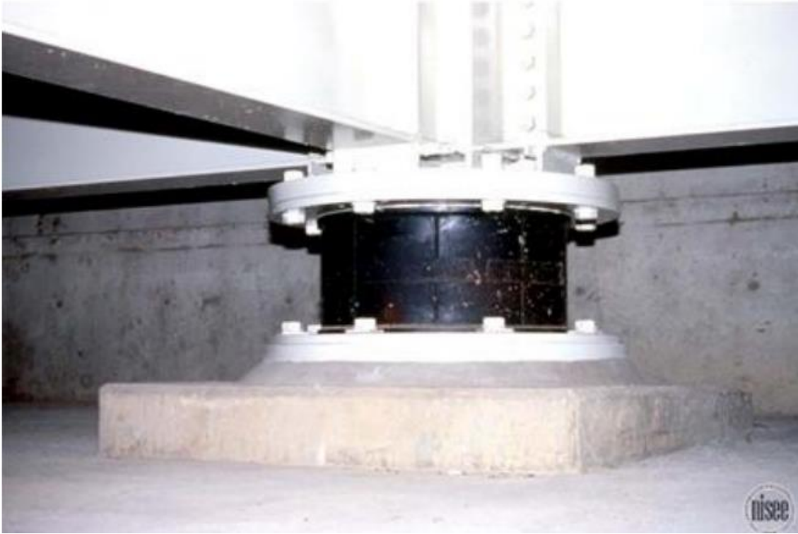
Figure I. 6 : Isolateur de caoutchouc à fort amortissement du bâtiment de réserve d'urgence de County Los Angeles (Creator, Aiken, Ian D. James M. Kelly Collection: NM0034. Courtesy of NISEE)
