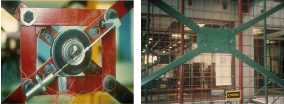
Figure I. 21 : L'amortisseur de Pall et son installation (Ian Aiken, 2006)
