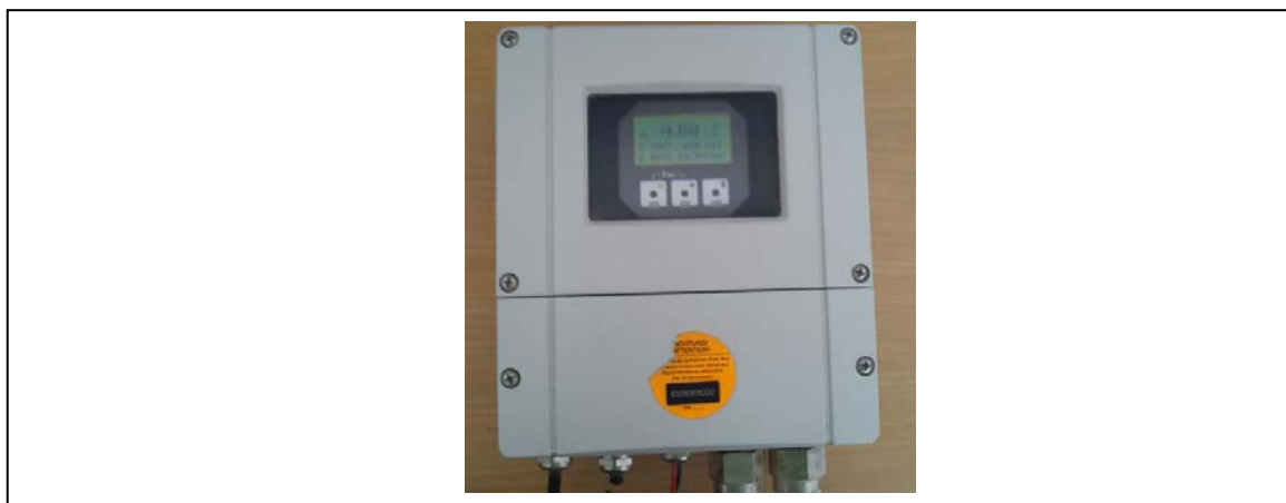
Figure I-8 Débitmètre à ultrason Flowmeter 93W2
