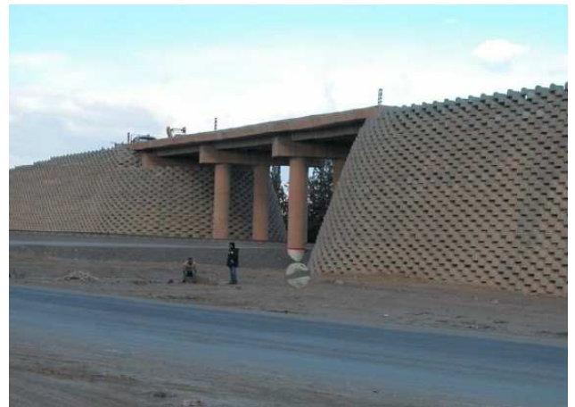
(b) Ouvrage terminé.
