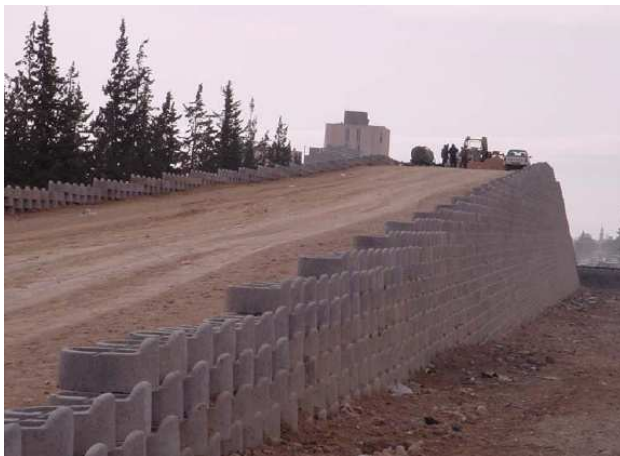
(a) Vue de l'ouvrage.
