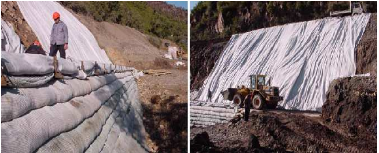
Figure 2.16 – Construction de l'ouvrage par couches.
