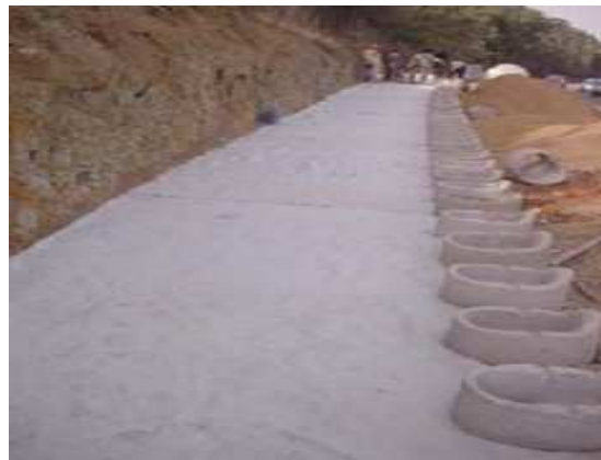
Figures 2.14 – Vue de l'ouvrage (Alger).
