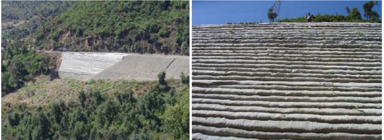
Figure 2.17 – Vue de l'ouvrage achevé.
