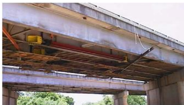
Figure 2.33 : Amortisseur à orifice variable [50]
