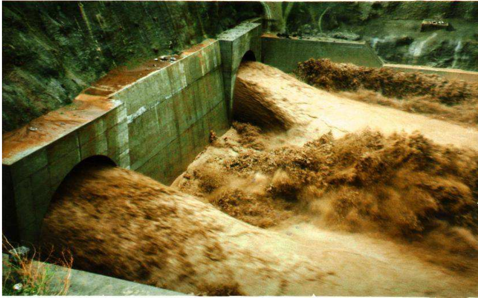
Figure II.4 Galeries de dérivation du barrage
