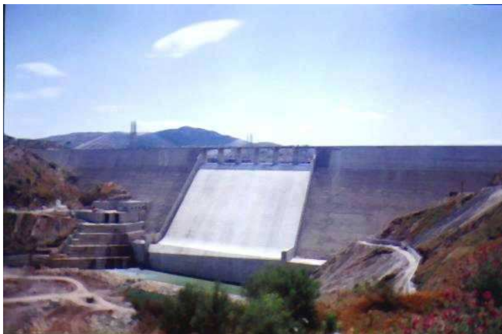
Figure II.3 Vue de l'évacuateur de crue du barrage de Beni-Haroun
