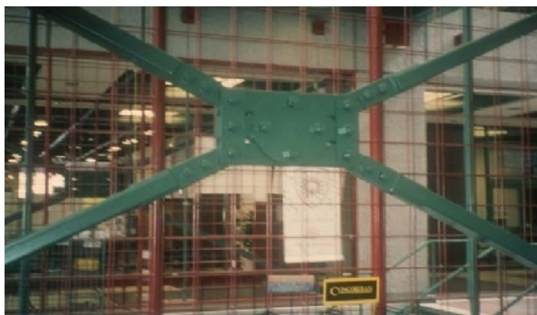
Figure 1.8 : amortisseur à friction
