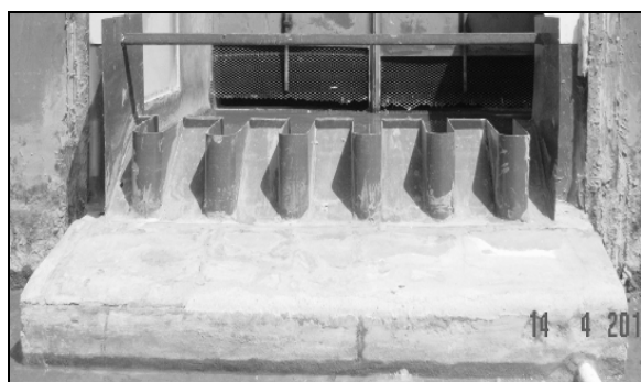
Figure II.24 : Radier sur toute la hauteur de l'alvéole amont.
