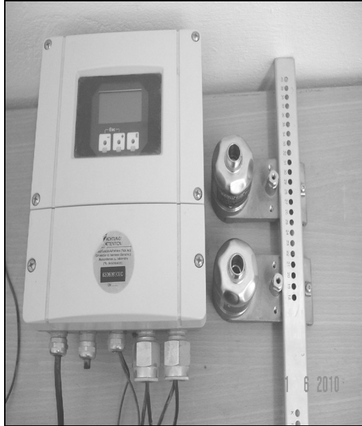
Figure I.14 : Débitmètre à ultrason Flowmeter 93W2
