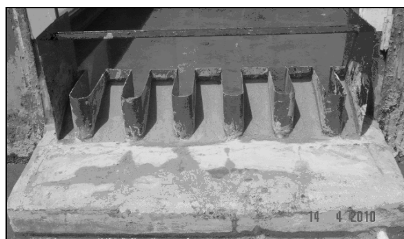
Figure II.25 : Radier sur les 2/3 de la hauteur de l'alvéole amont.
