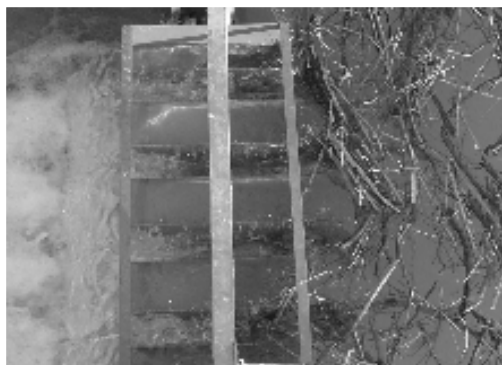
Figure II.43: Fonctionnement du PK-Weir avec encombrement de l'entrée par des corps flottants
