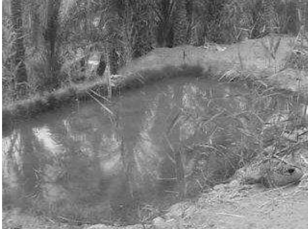
Photo. I.34. Madjen en terre bien nettoyé ciment (Remini B., 2007)
