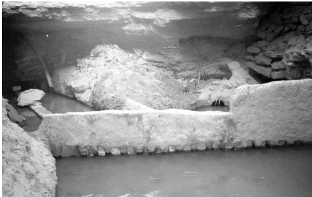
Fig. I.24. Tranquillisateur (ancien) d'une Kasria (Remini B., 2003)
