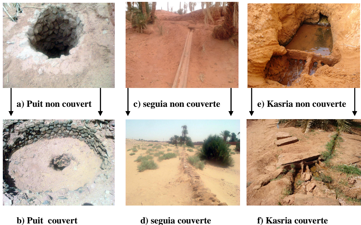
Fig. V.3. Ouvrages de la foggara de l'Erg cachés sous sol (photos Remini B., 2007)
