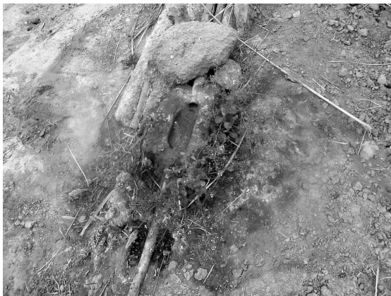
Fig. I.39. Ouverture dans une seguia fermée (conduite en PVC) (Photo. Remini B., 2007)
