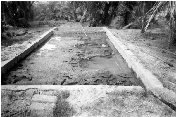
Photo. I.33. Madjen en ciment (Photo. Remini B.)
