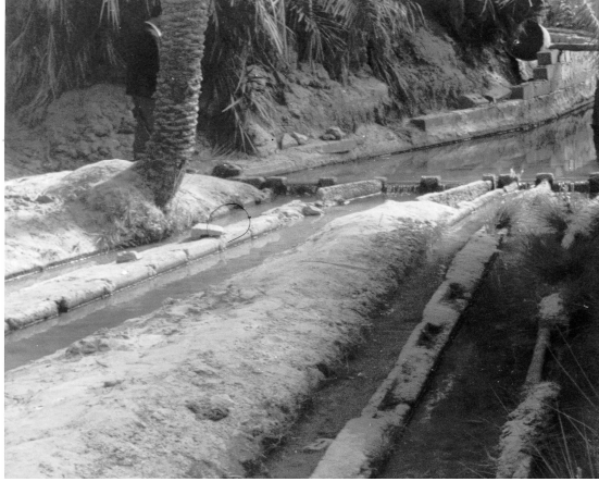
Fig. I.40. Enchevêtrement des seguias (Photo. Remini B. 2000)
