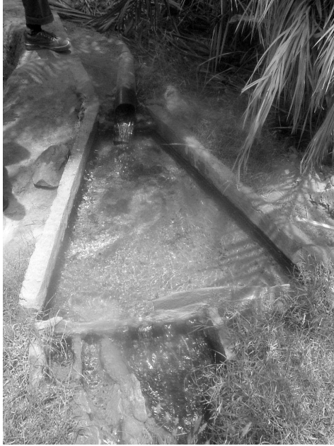
Fig. I.25. Kasria allongée dans la région de Timimoun pour minimiser la turbulence de l'eau à l'arrivée de l'eau (Remini B., 2007)
