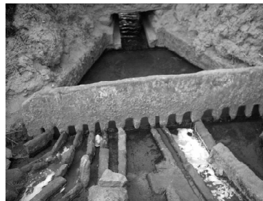
Fig. V.4. Kas ria de la foggara de l'Erg plus allongée que celle de la foggara classique (Remini B., 2008)
