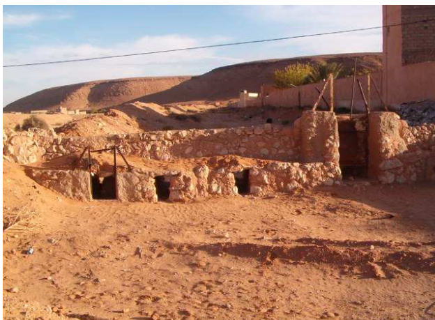
Fig. IX.40. Ahbas de Touzouz avec vanne Coulissante (Remini B., 2007)
