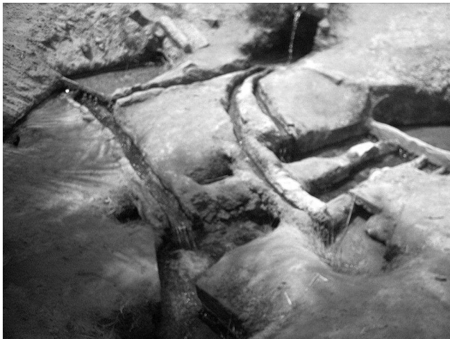
Fig. I.26. Groupement de 3 Kasriates (Remini B., 2007)
