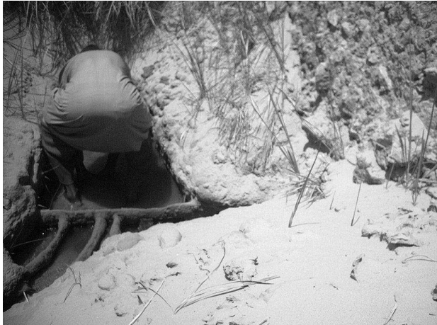
Fig. XIII. 13. Curage périodique d'une Kasria de la foggara de Badou (Remini B., 2007).
