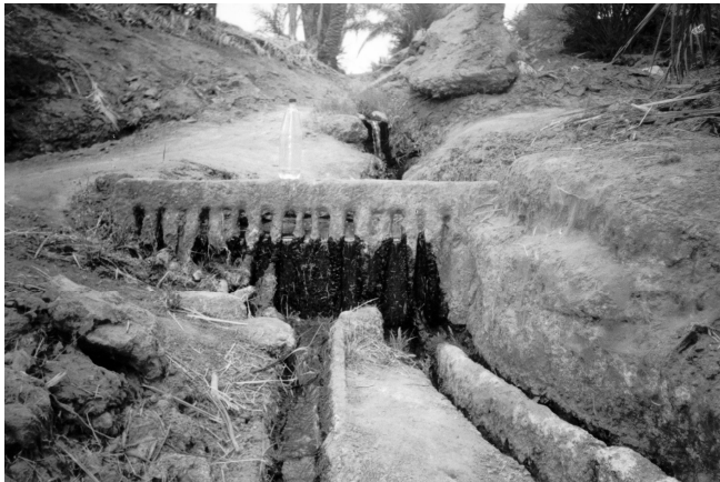
Fig. I.28. Kasria secondaire d'une petite foggara de Timimoun (Photo. Remini B.)
