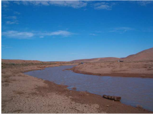
Fig. IX.38. Retenue de Bouchene (Remini B., 2007)
