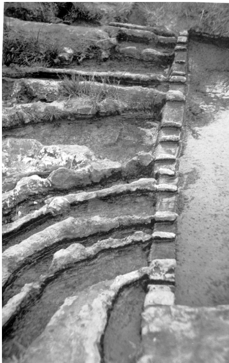
Fig. I.21. Autre type de Kasria principale (Remini B., 1998)
