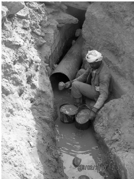
Fig. IV.13. Opération de réhabilitation des foggaras dans le Touat en 2010 (photo. Nouh et Remini B.)
