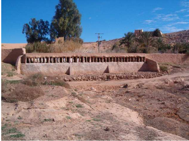
Fig. IX.41. Déversoir de Bouchene (Remini B., 2007)
