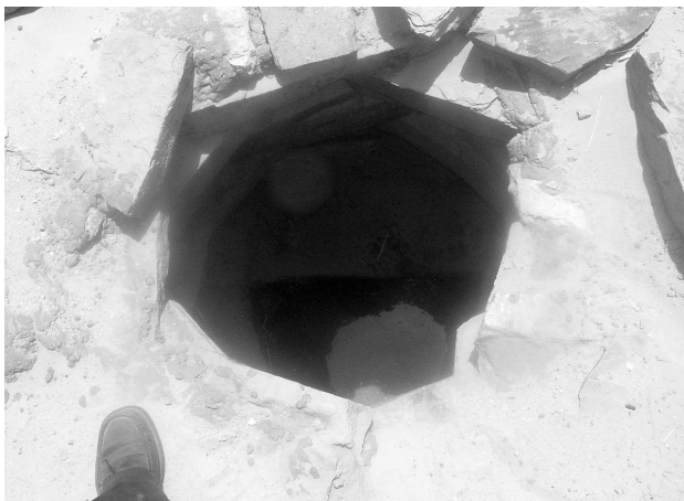
Fig. I. 13. Puit aménagé (Remini B., 2007)
