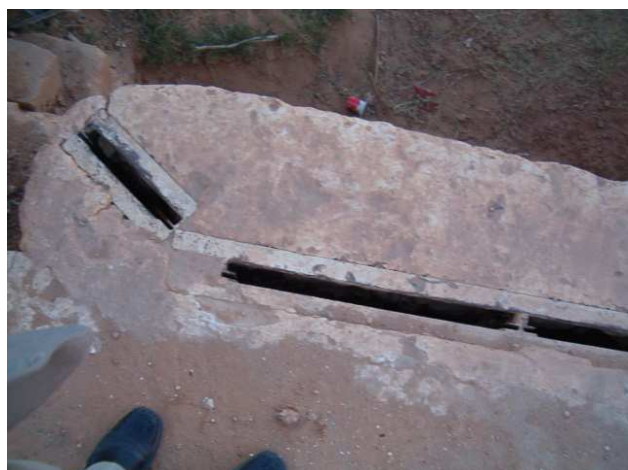
Fig. IX.24. Ouverture par laquelle glisse une porte métallique (Remini B., 2007)
