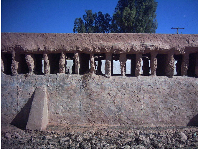
Fig. IX.21. Déversoir avec Machte (Remini B., 2007)
