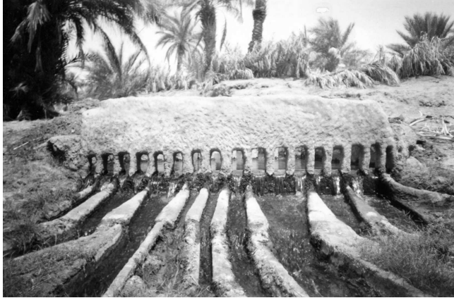
Fig. I.27. La grande Kasria secondaire de la foggara d'El Meghier (Photo. Remini B.)
