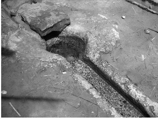
Fig. I.38. Seguia en ciment au centre d'un ksar muni d'une ouverture de même dimensions qu'un seau.(Photo. Remini B., 2007)
