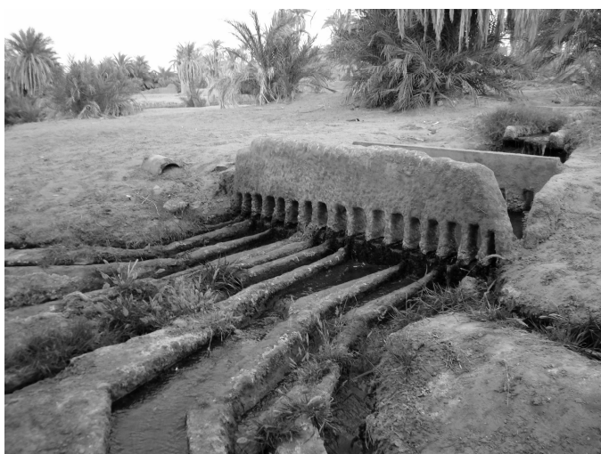
Fig. XIII. 3. Le grand Peigne (Répartiteur de débit) de la foggara d'El Meghier (Timimoun) (cliché Remini B., 2008)
