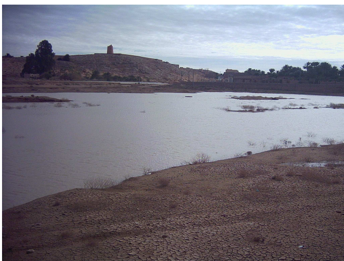
Fig. IX.5. Barrage Bouchene (photo. Remini B., 2007)
