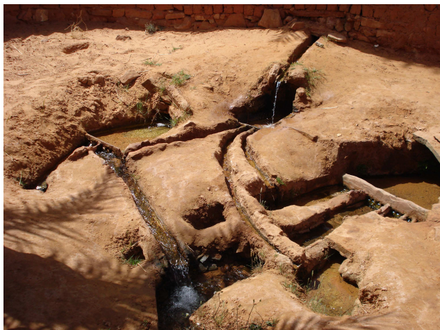
Fig. XII.9. Raccordement des foggaras Entrite, Amokrane et Badgha (photo. Remini B., 2008)
