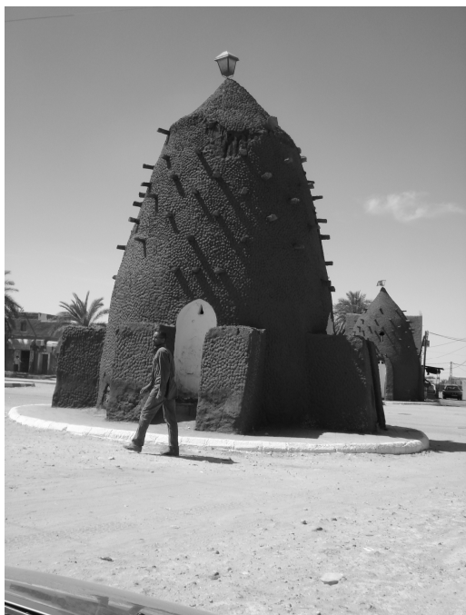
Fig. XIII. 2. Un puit de la foggara au centre ville de Timimoun (cliché Remini B., 2008)
