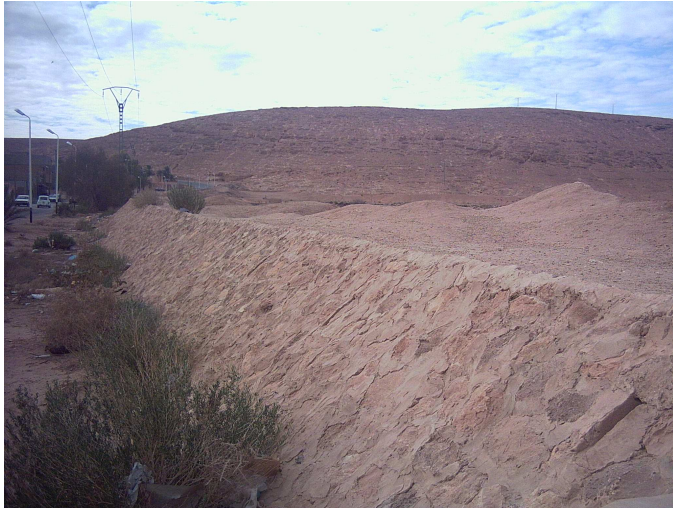
Fig. IX.6. Barrage de Touzouz (photo. Remini B., 2007)
