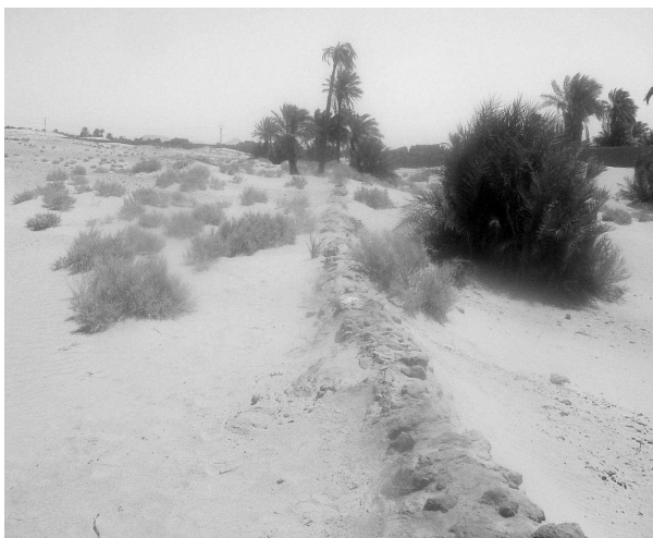
Fig. XIII. 14. Couverture de la seguia par des dalles plates rocheuses Un moyen de lutte contre l'ensablement (Remini B., 2007)
