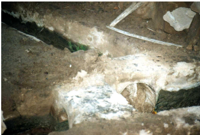
Fig. X.11. Aménagement des ouvertures pour la fermeture manuelle des seguias (Remini B., 2007)
