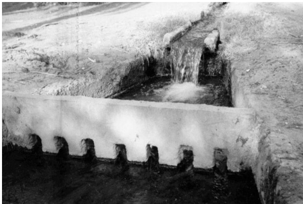
Fig. I.23. Tranquillisateur d'une Kasria (Remini B., 2003)
