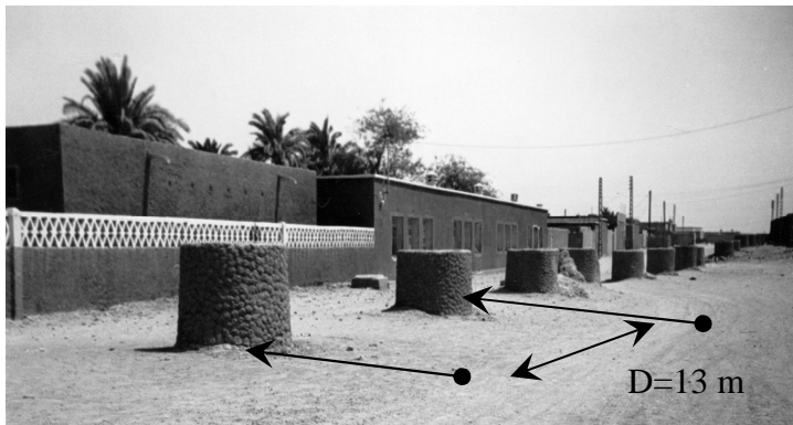
Fig. I.41. Une succession de puits dans la ville d'Adrar. La distance est presque constante (Remini B., 1998).
