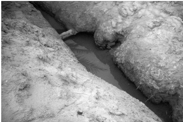
Fig. VII.4. Kasria de la foggara de Zahzah (foggara de jardin) dans le Ksar de Beni Mehllal (Remini B., 2007)
