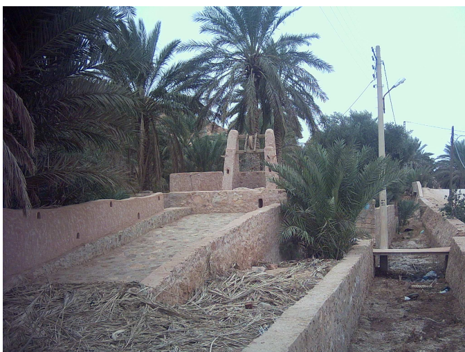
Fig. IX.32. Piste inclinée sur laquelle circule l'animal (Remini B., 2007)
