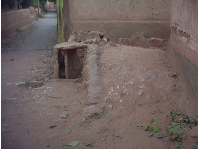
Fig. IX.29. Koua avec un obstacle frontale (Remini B., 2007)
