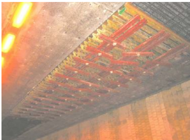
Phot. 1.3 - Coffrage utilisé pour les travaux de réparation de la voûte au Tunnel Notre –Dame-grâce. [45]
