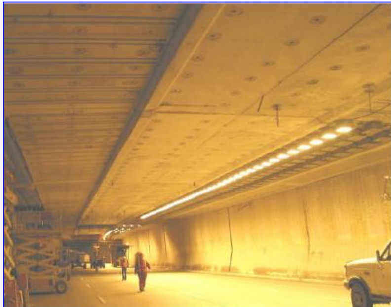
Phot. 1.4 - Aspect final des réparations [45]
