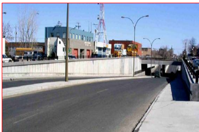
Phot. 1.7 - Passage inférieur Jarry/Querbes tel que construit [15]
