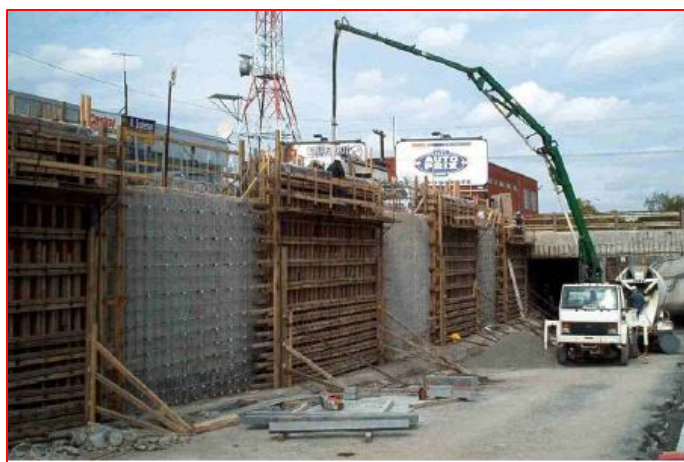
Phot. 1.6 - Mise en place du BAN. [15]
