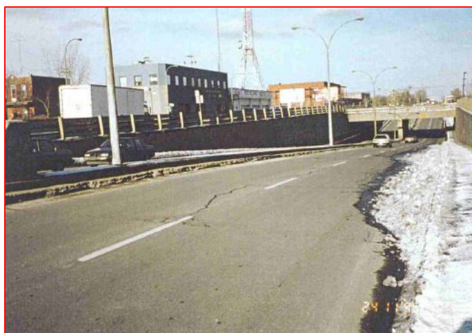
Phot. 1.5 - Passage inférieur Jarry/Querbes avant sa réfection [15]
