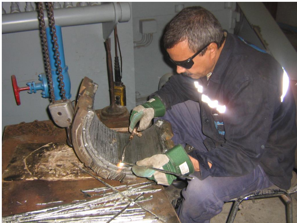
Fig. II.6: Poste de rechargement par soudure (MEI)
