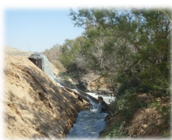
Figure 24: Rejet principal des eaux usées des la ville de Biskra (Originale)
