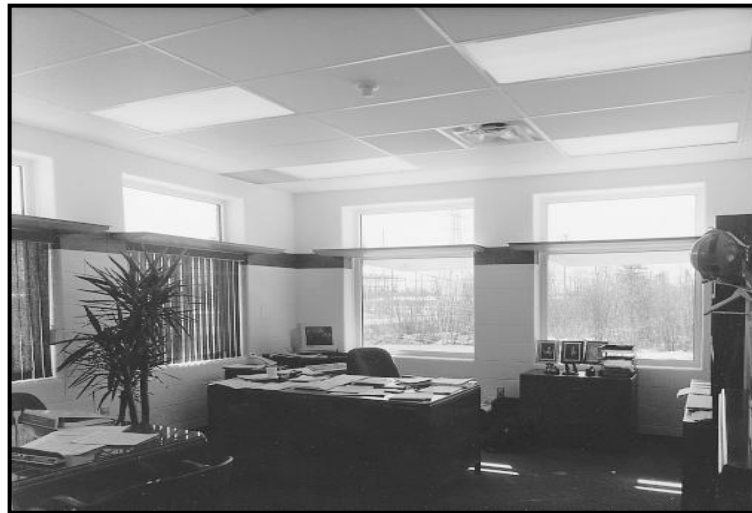
Figure 122 : Façade équipée d'un light shelf et d'un dispositif d'ombrage intérieur. (Source: ENERGY EFFICIENCY MANUAL, CONTROL AND USE OF SUNLIGHT)
