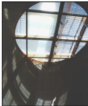
Figure 95 : L'intégration de holo-lux dans le plafond de bibliothèque de l'académie Mont Cenis, Herne. (Source : GLB )
