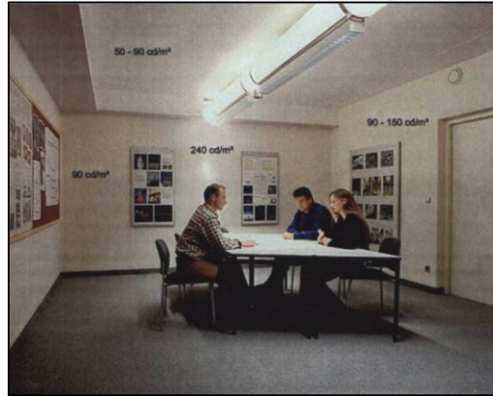
Figure 90: Le système Light pipe (Source : Bartenbach L'chtLabor)
