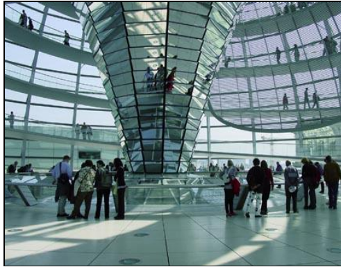
Figure 78 : Vue intérieure sur le cône lumineux du dôme Reichstag (Source : http://www.galinsky.com )
