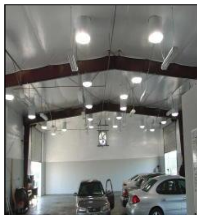
Figure 84 : Vue intérieure d'un puits de lumière. (Source: http://www.natureetconfort.fr )
