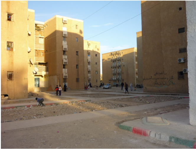
Photo N° 30 : Espace extérieur dénudé
