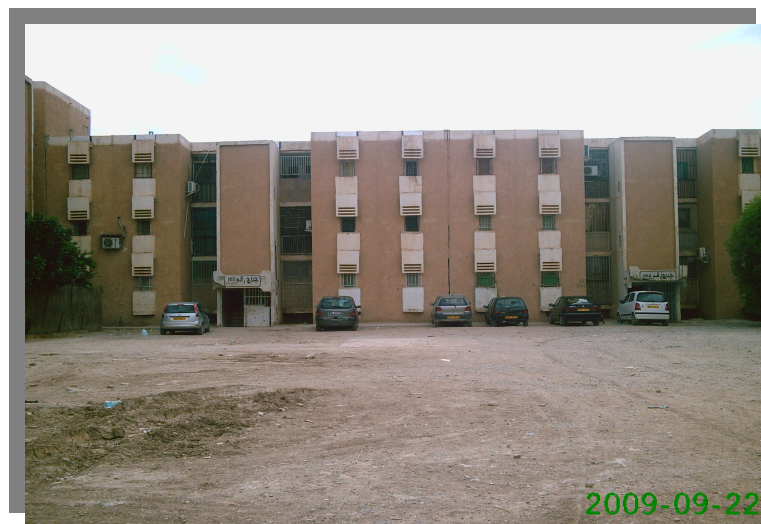
Photo N° 11: les entrées sont imperceptibles
