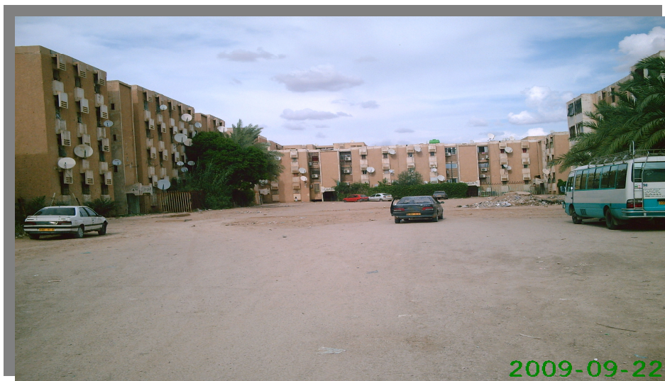
Photo N°26 : Espace central vide
