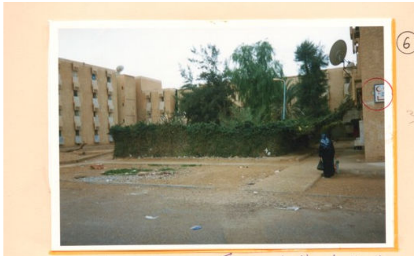
Photo N°27 / Tentative exemplaire jardinage au niveau de l'espace central
