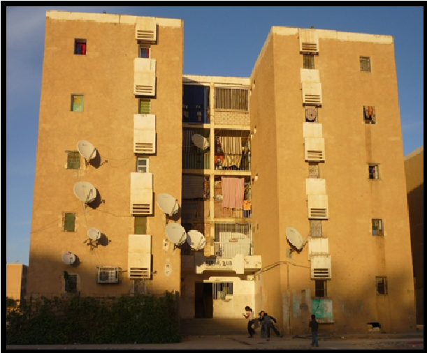
Photo N°10 : Bloc En RDC+4
