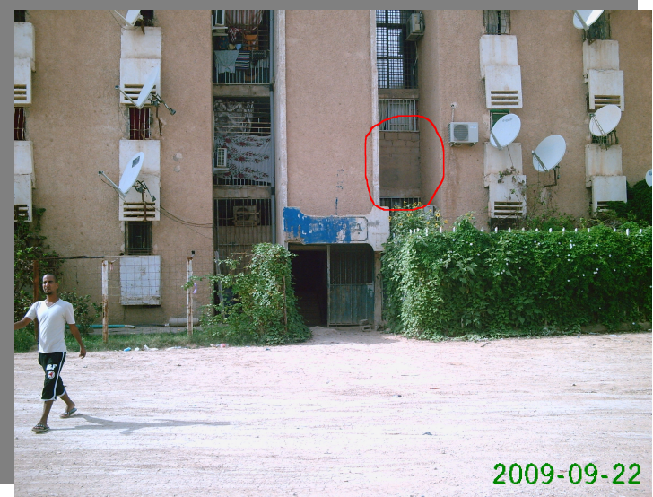
Photo N°16/ La fermeture des balcons et détournement d'usage
