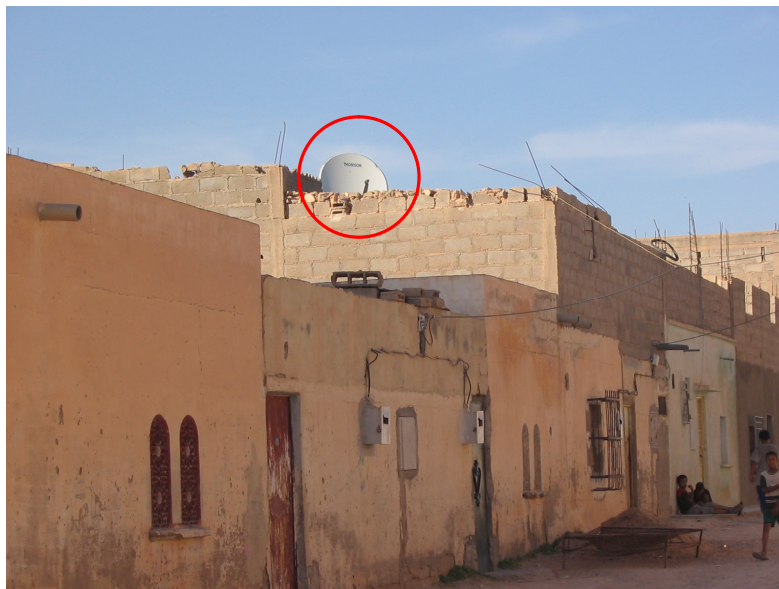
Photo 23 : Présence remarquable d'antennes paraboliques sur les terrasses
