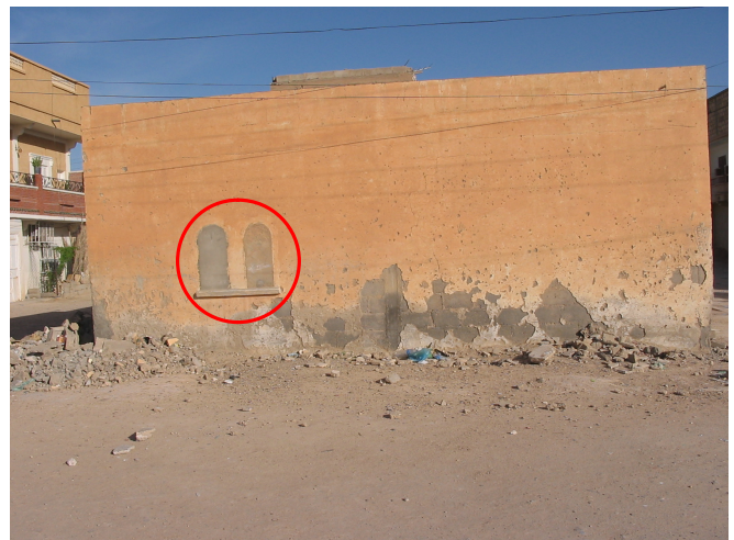
Photo 15 : Claustras bouchés d'une maison construite par l'Etat
