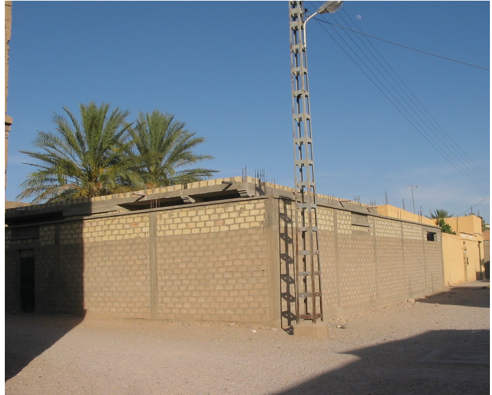
Photo 13 : Mur de clôture élevé par le Propriétaire de la maison.
