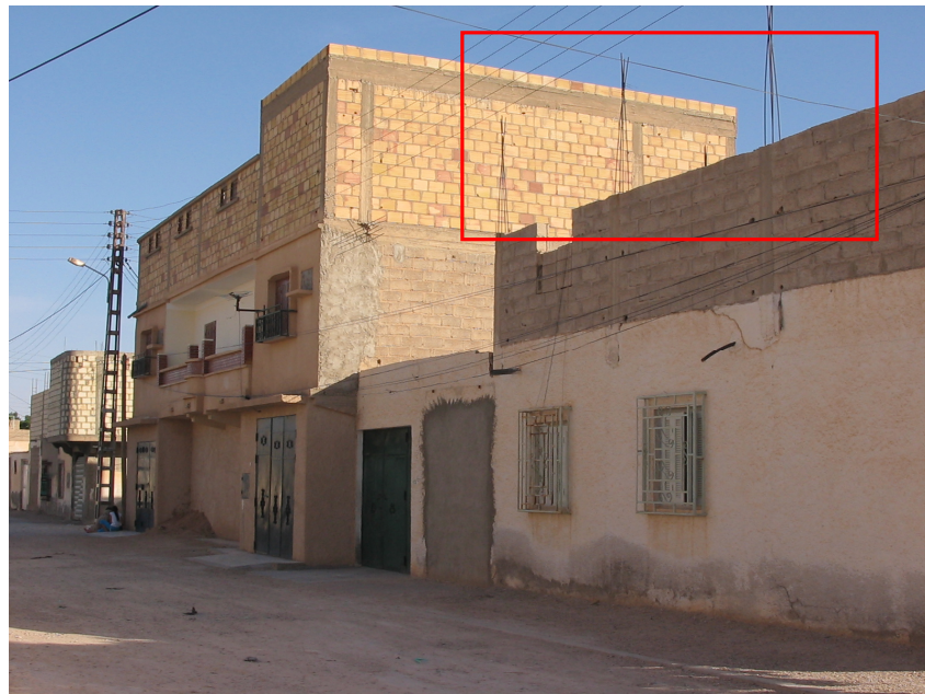
Photo 4 : Chantiers sans délais de réalisation précis
