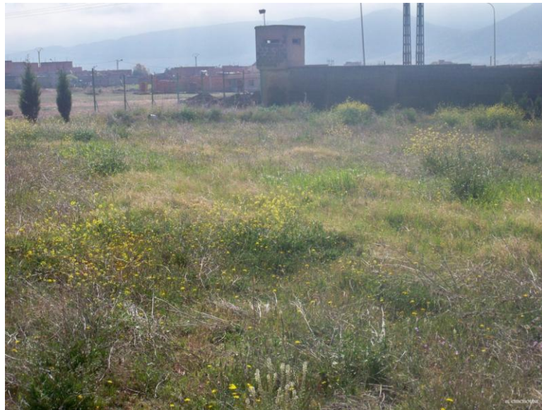
Figure 20: Vue générale de la station Fesdis (auteur).
