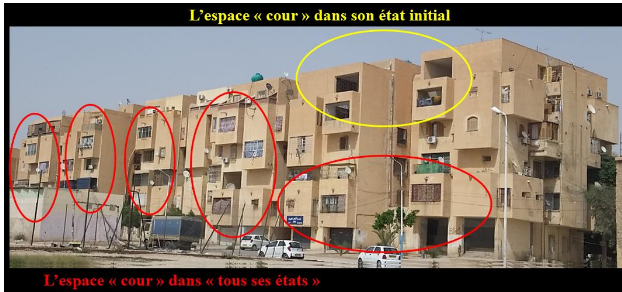
Figure 8-9. les altérations subies par l'espace cour dans son essence d'un espace à double hauteur, doublement ouvert sur l'extérieur. (Source : auteur, 2019)
