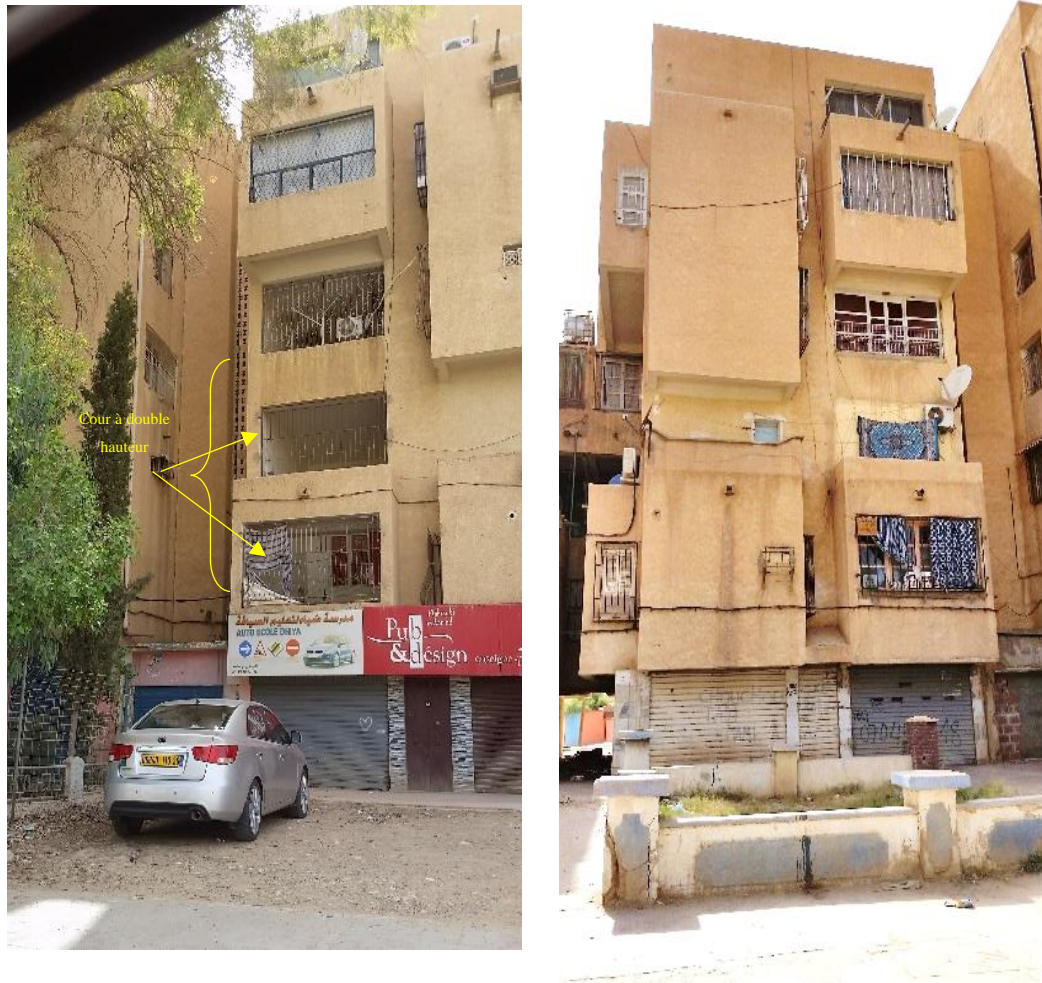
Figure 5-29. vue sur les espaces cours, à double hauteur, des logements - à gauche à leur état initial, à droite fortement modifiés. (Source: Auteur, 2017)
