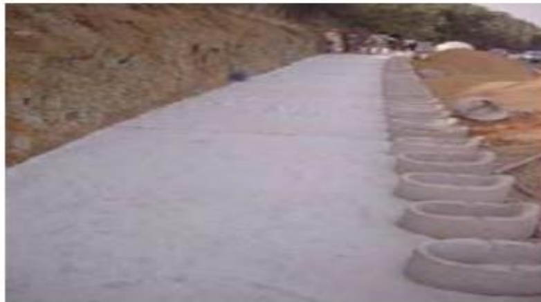
Figure 1-6 Mur en sol renforcé wilaya d'Alger.
