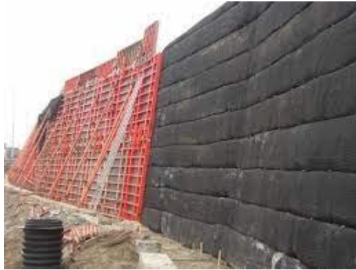
Figure 1-4 Mur en sol renforcé à parement flexible.
