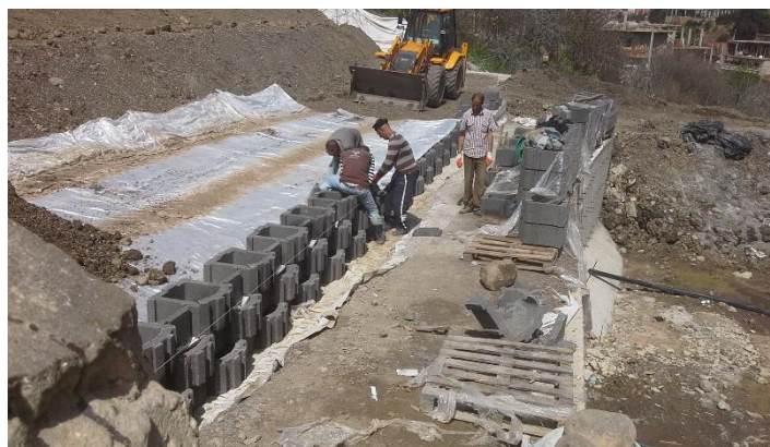
Figure 1-3 Mur en sol renforcé à parement semi-rigide.
