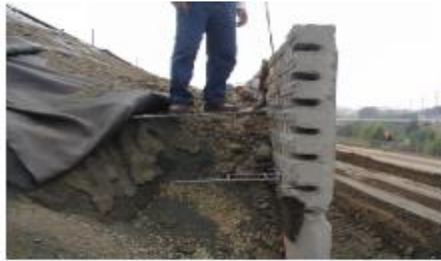
Figure 1-2 Mur en sol renforcé à parement rigide (Rahmouni, 2017).
