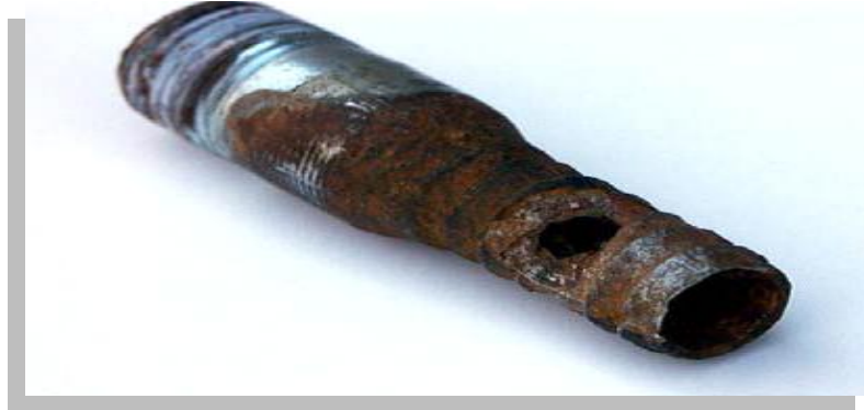
Fig. I. 8. Corrosion érosion d'une pièce de machine à Laver.
