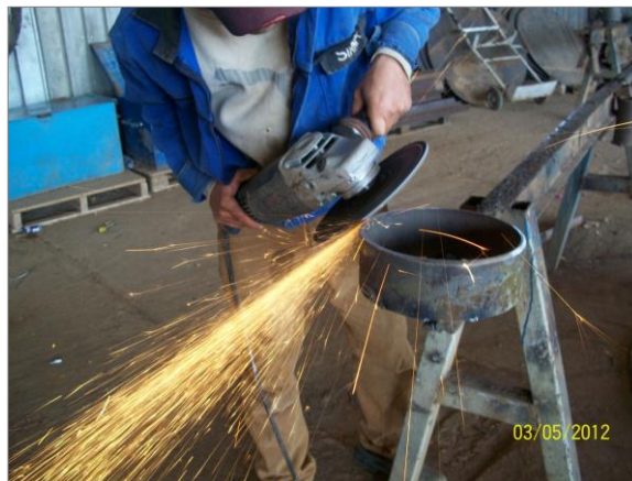
Figure 62: Préparation du chanfrain.
