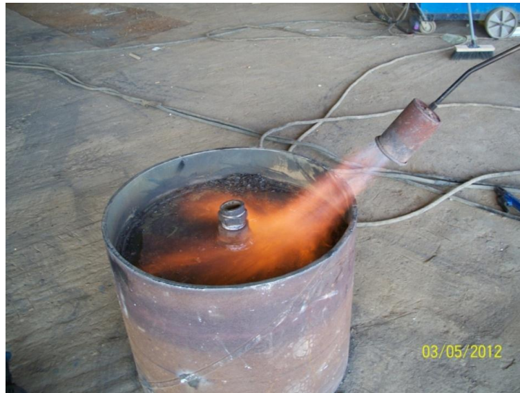
Figure 117 : Traitement d'un cordon de soudure par chauffage.
