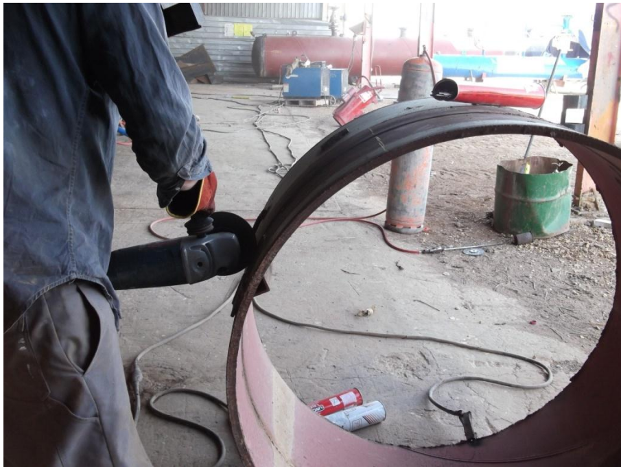
Figure 119 : Enlèvement de la matière du cordon de soudure.
