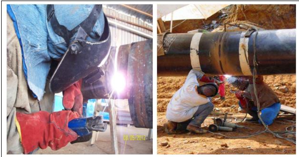
Figure 8 : Soudage des pipelines (type manuel).
