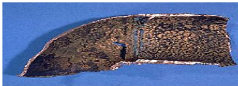
Fig I.7 . Corrosion érosion d'un tube en cuivre véhiculant de l'eau [7].
