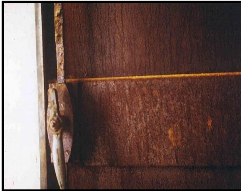
Fig. I.3 : Corrosion uniforme.
