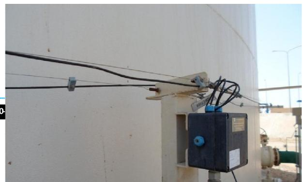
Fig. II.7 : câbles thermosensibles (skid gaz)
