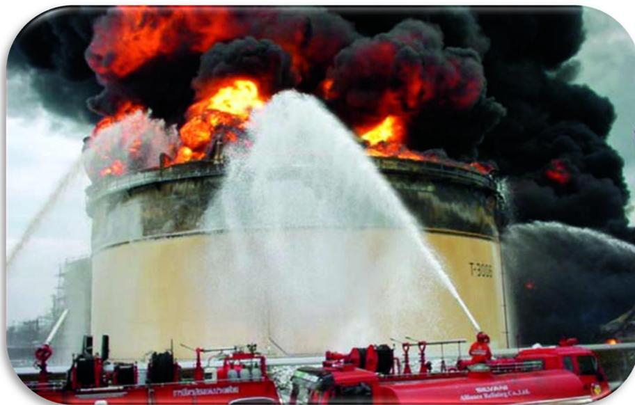
**Fig. II.19** : refroidissement du bac de stockage
