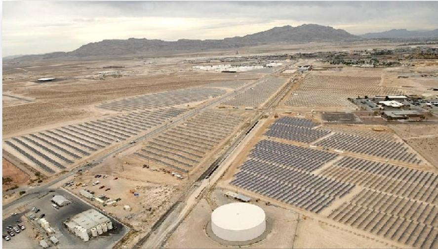
Figure (II.3) : Le Nellis Solar Power Plant comprend 72 000 panneaux solaires photovoltaïques sur 140 acres (soit 54 ha) (Centrale Solaire Photovoltaïque)
