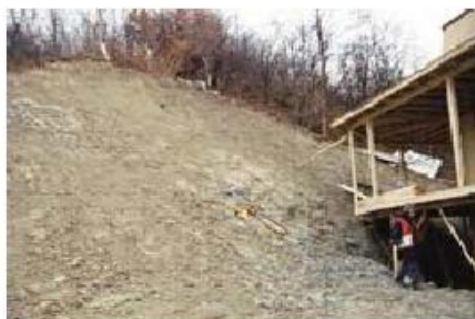
Déblai à la base du talus
