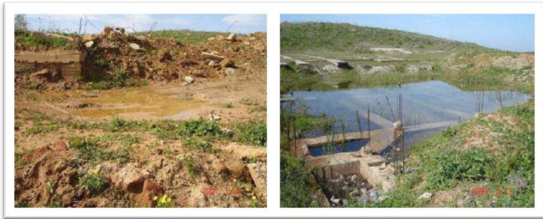
Figure 1.24: Stagnation des eaux en amont dans des fondations abandonnées.
