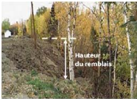
Remblai en sommet du talus
