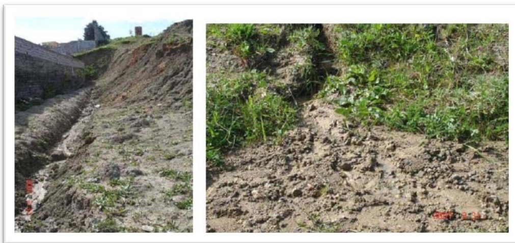
Figure 1.24: Stagnation des eaux en amont dans des fondations abandonnées.
