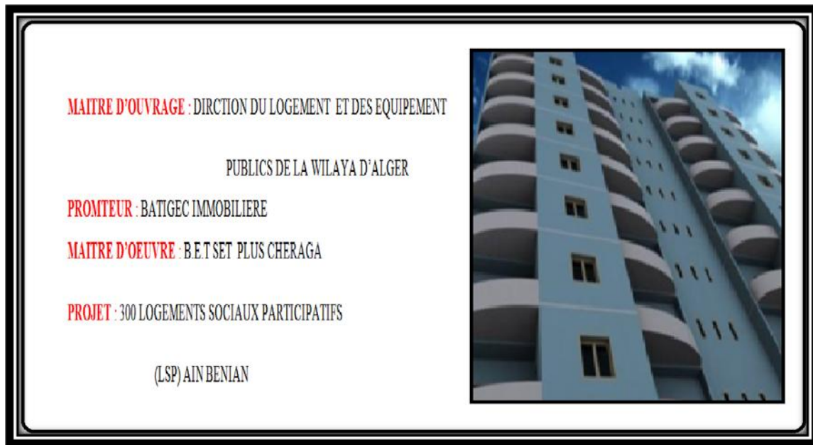
Fig. 2: Panneau de chantier.
