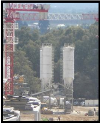
Fig.11: la Centrale à béton.
