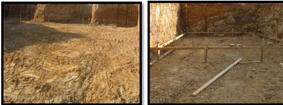
Fig.38 : Les chaises pour matérialiser l'emplacement des semelles
