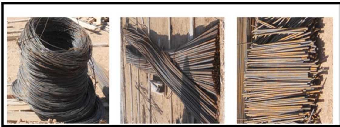
Fig. 21 : Stockage des aciers non façonnés
