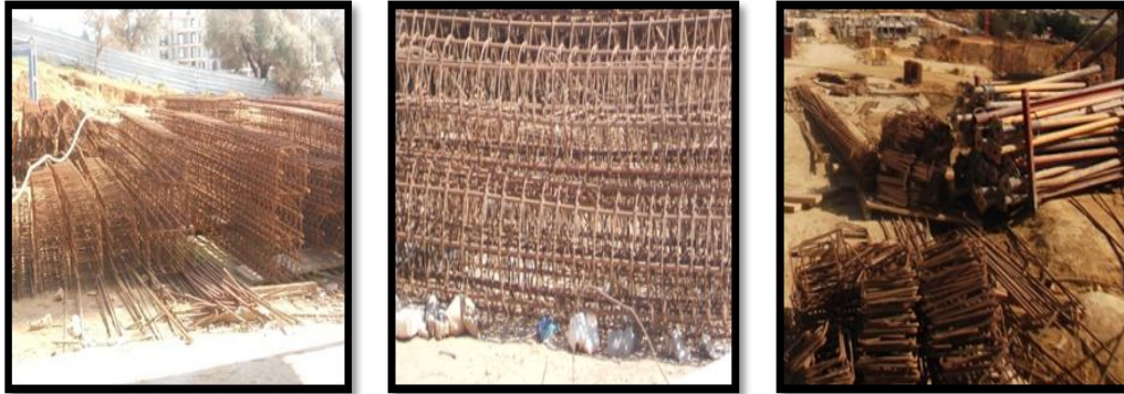
Fig. 23: Stockage des éléments façonnés (poteaux, poutre)
