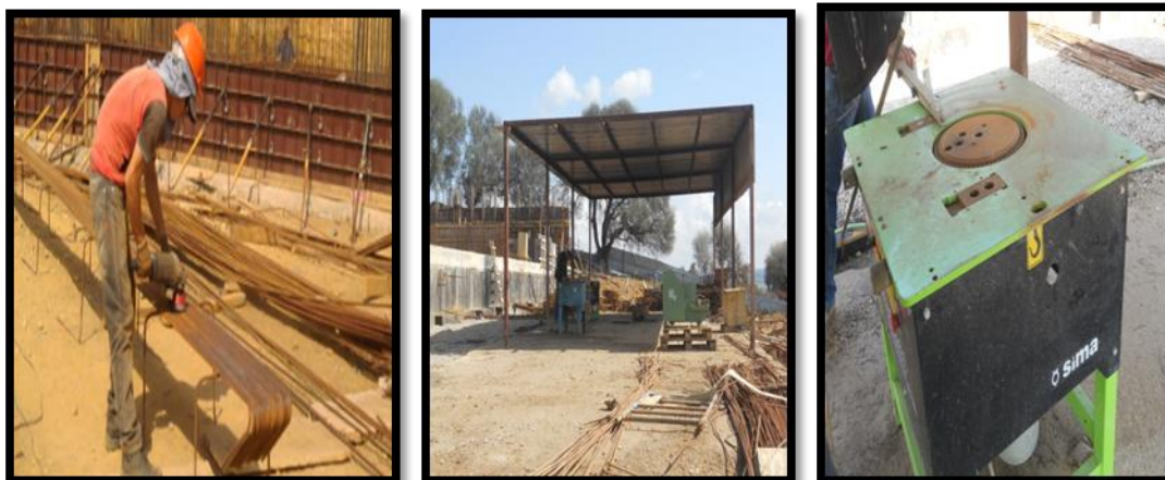
Fig. 22: Matériel de façonnage des aciers
