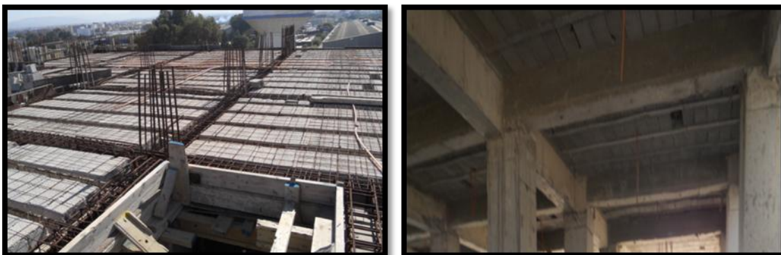
Fig.48 : planche après le coulage.
