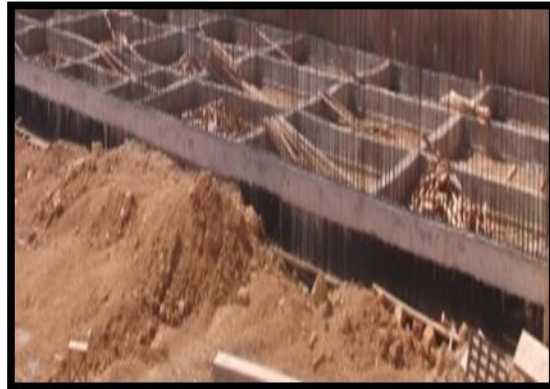
Fig.43: décoffrage des longrines
