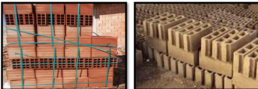
Fig.25: Stockage corps creux et brique.
