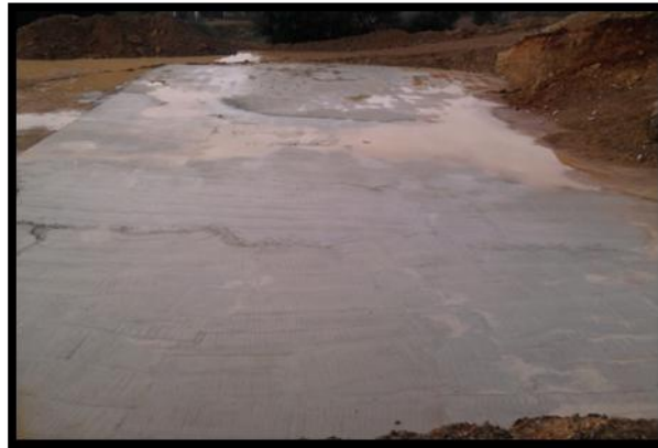
Fig.39: Coulage du gros béton
