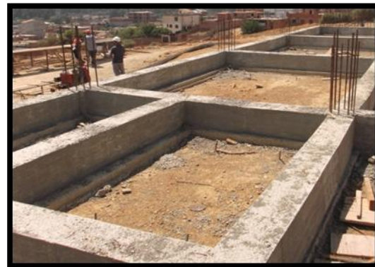
Fig.44 : Le remblai de la dalle.
