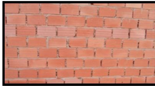
Fig52 : Mur en maçonnerie
