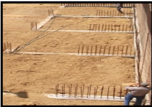
Fig.44 : Le remblai de la dalle.
