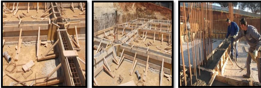
Fig.41 : Coffrage et Coulage du béton des semelles.
