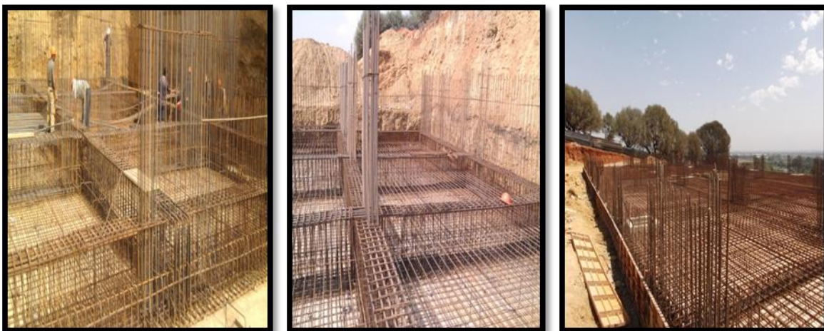
Fig.40 : Ferrailage du radier nervuée
