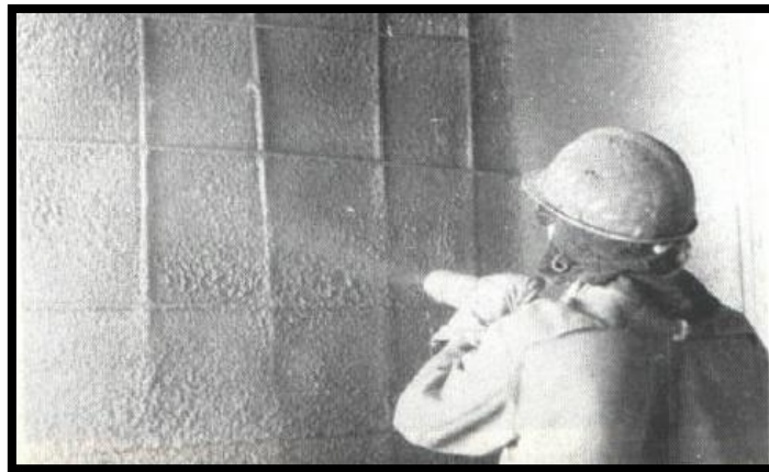
Photos I.3: Le béton de sable en projection.
