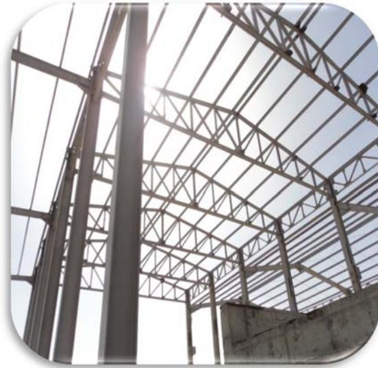
**Fig.45. :** Les fermes à treillis après le montage (chantier 1)
