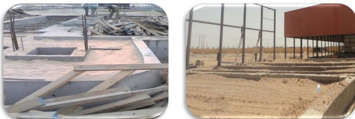
**Fig.35** : Remplir les vides avec du sol propre (chantier 1 et 3)
