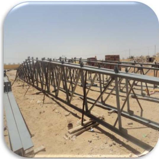
**Fig.44 :** les fermes à treillis avant le montage (chantier 3)
