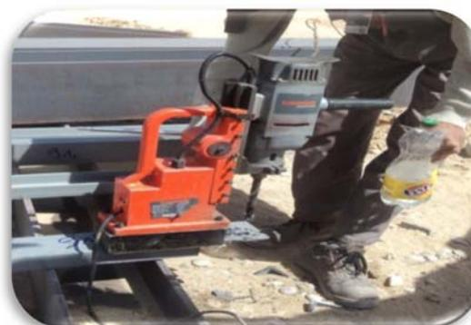
**Fig.31** : le perçage des trous
