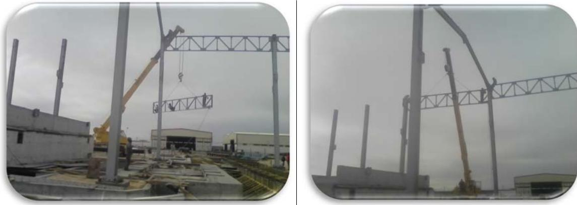
**Fig.39** :Montage des poutres en triellis (chantier 1)
