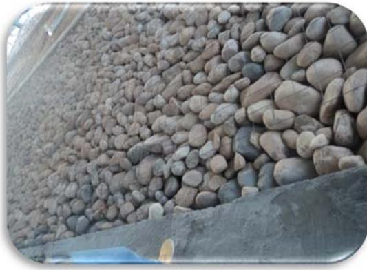
**Fig.36 :** Combler avec des pierres
