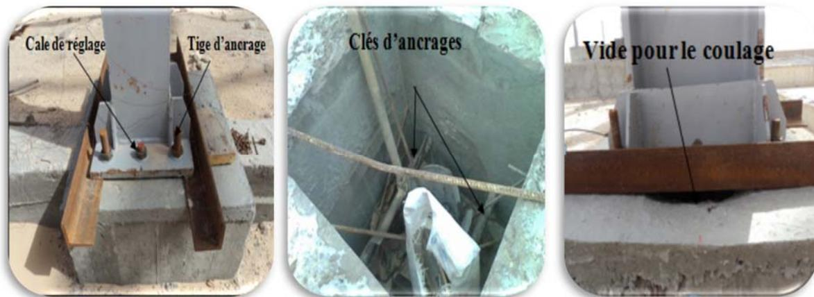
**Fig.34** :Les détails de fixation des poteaux (chantier 1)
