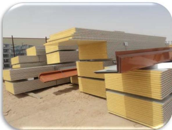
**Fig.7 :** stockage des panneaux sandwich
