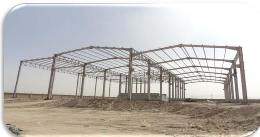
**Fig.2** : Montage de la structure principale de l'unité de galvanisation
