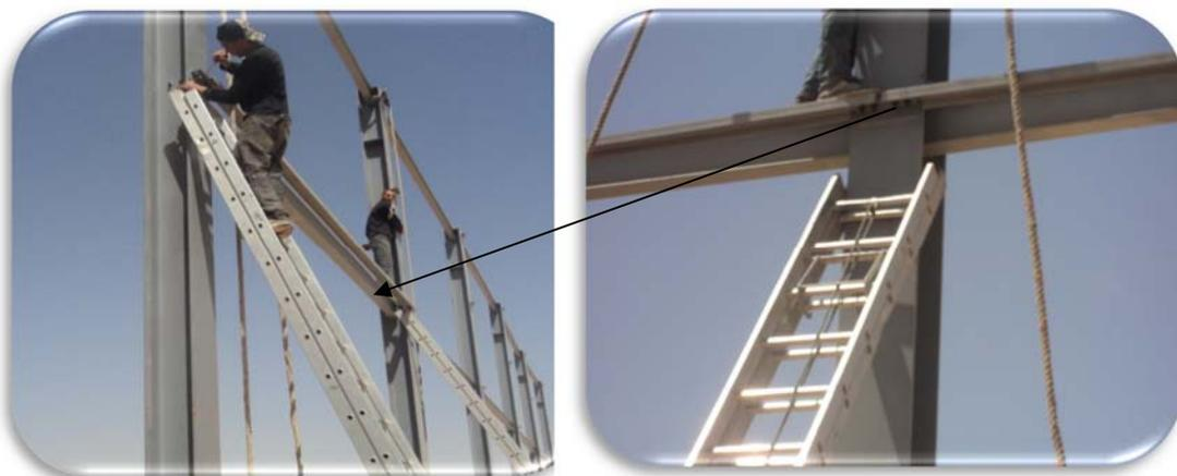
**Fig.41** : Le montage des lisses de bardage
