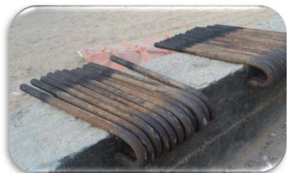
**Fig.33 :** Les Tiges d'ancrages
