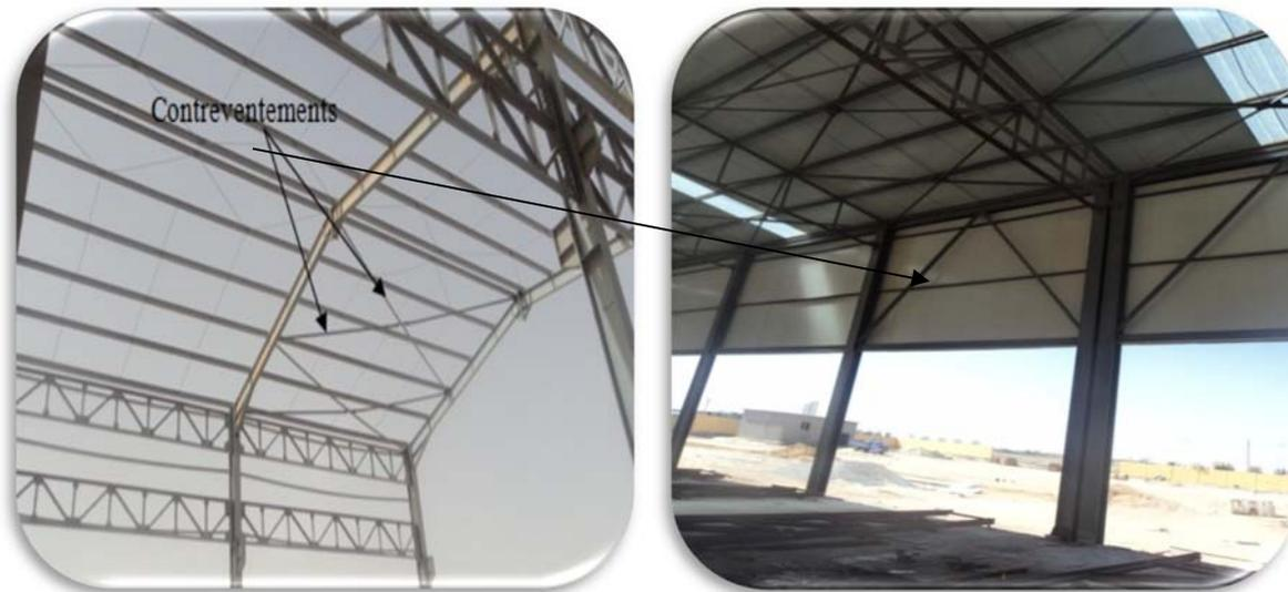
**Fig.47 :** Les contreventements (chantier 1et 3)
