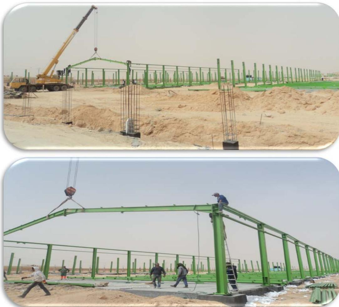
**Fig.3 :** Montage de la charpente du hangar de caserne de gendarmerie
