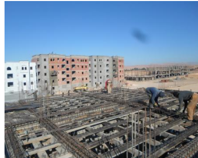
Figure 42 : ferrailage de plancher
