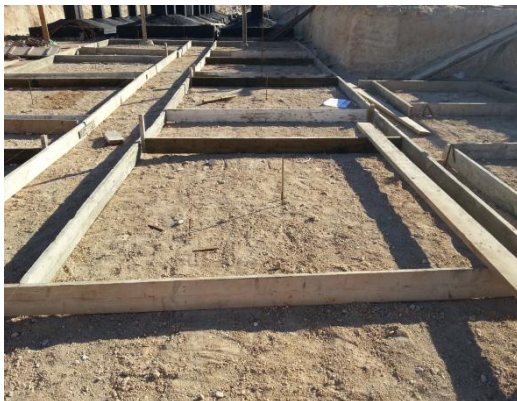
Figure 22 : coffrage de béton de propreté
