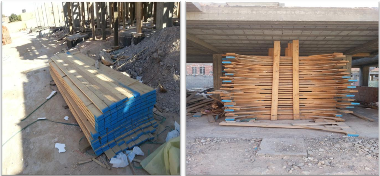
Figure 12 : stockage du coffrage
