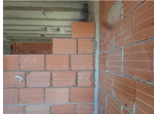
Figure 52 : murs de séparation
