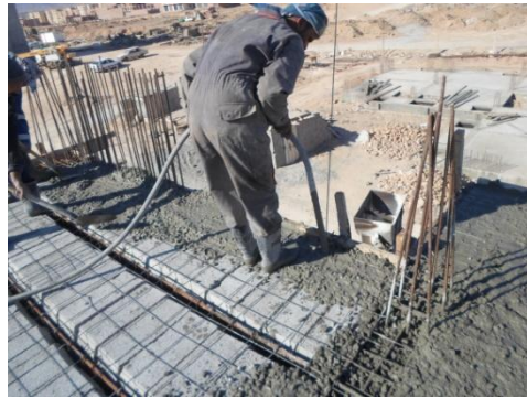
Figure 40 : coulage des poutres
