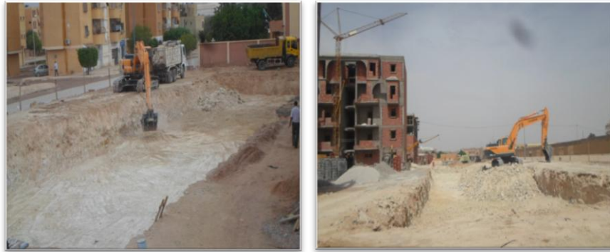
Figures 18 : terrassement de terrain
