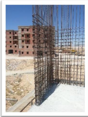
Figure 35 : ferrailage de voile Figure 36 : coffrage de voile Figure 37 : décoffrage de voile
