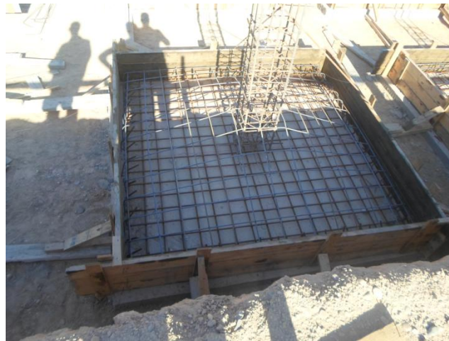
Figures 24 : Ferrailage et coffrage de semelle carrée
