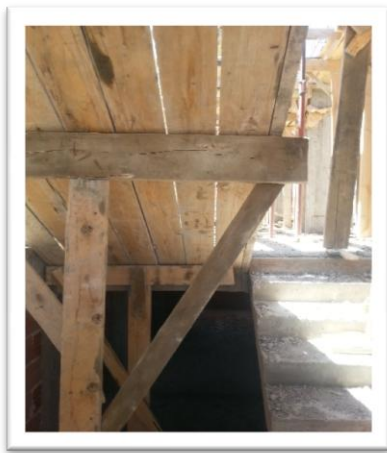
Figure 45 : coffrage d'escalier Figure 46 : ferrailage d'escalier Figure 47 : coulage d'escalier
