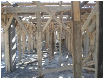
Figure 41 : coffrage de plancher
