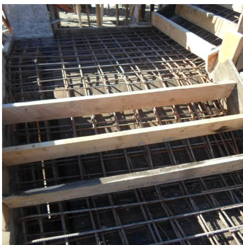
Figure 48 : ferrailage de palier de repos
