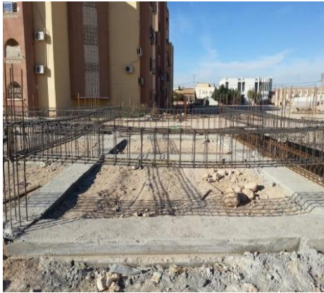
Figure 29 : Gros béton de longrine
