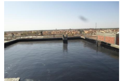
Figure 62 : 1ere couche de bitume
