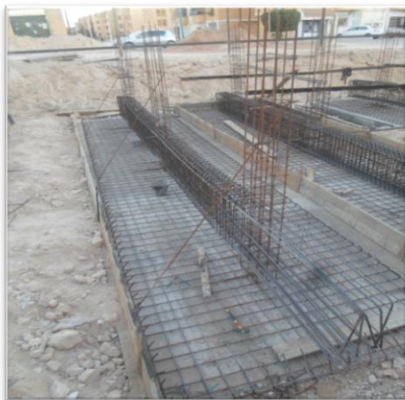
Figures 25 : Ferrailage de semelle filante
