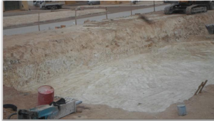
Figure 21 : Le fond de fouille est bien fini
