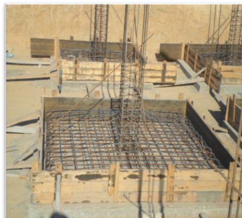
Figures 26 : Ferrailage et coffrage de semelle rectangulaire
