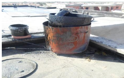
Figure 61 : bitume chauffé
