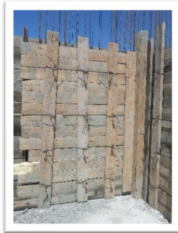
Figure 35 : ferrailage de voile Figure 36 : coffrage de voile Figure 37 : décoffrage de voile
