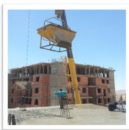
Figure 44 : coulage de plancher
