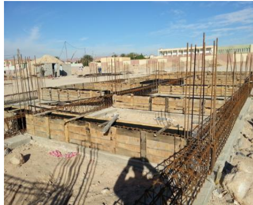
Figure 30 : ferrailage et coffrage de longrine
