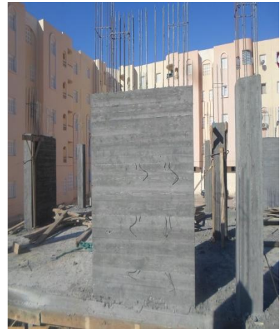
Figure 35 : ferrailage de voile Figure 36 : coffrage de voile Figure 37 : décoffrage de voile
