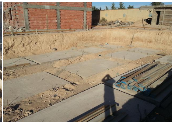
Figure 23 : béton de propreté
