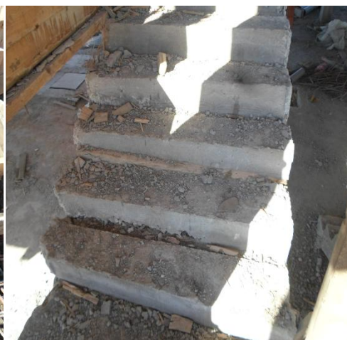
Figure 49 : coulage d'escalier -
