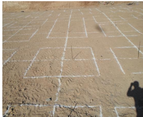
Figure 19 : le piquetage et traçage
