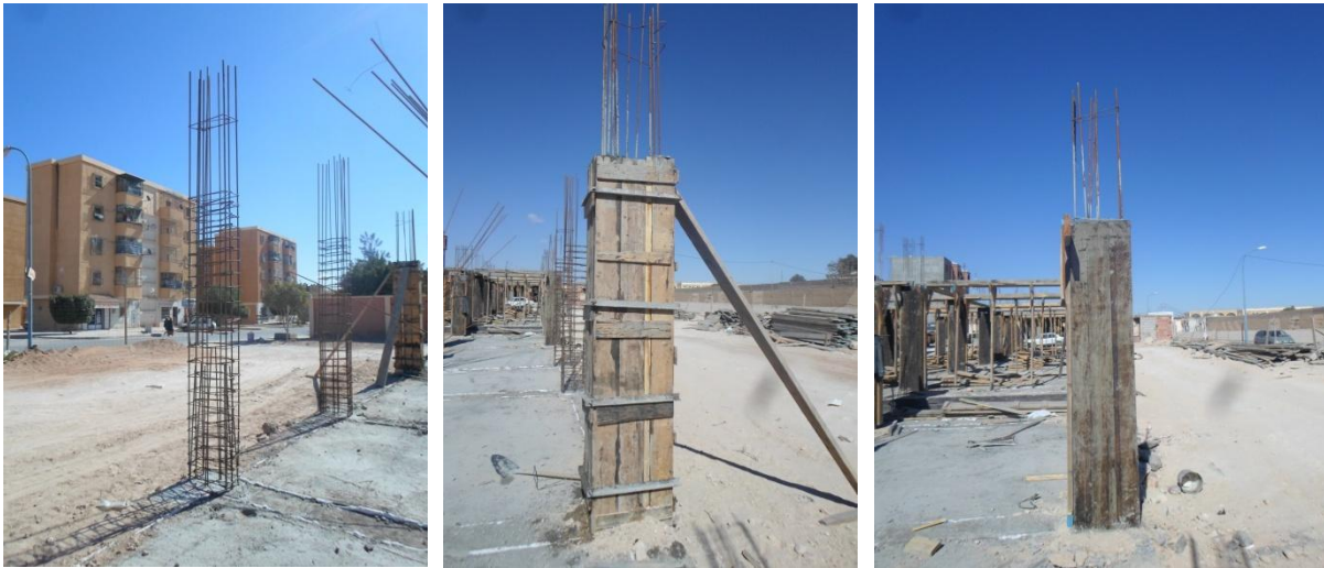
Figure 32: ferrailage de poteau Figure 33 : coffrage de poteau Figure 34 : décoffrage de poteau
