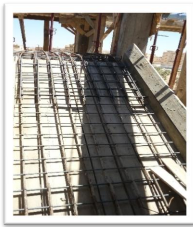
Figure 45 : coffrage d'escalier Figure 46 : ferrailage d'escalier Figure 47 : coulage d'escalier
