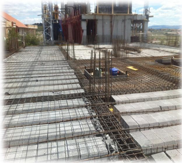
Photo.40. Le plancher avant le coulage de béton
