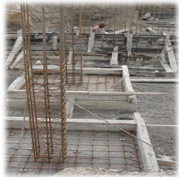
Photo.28. Ferrailage d'une semelle isolé.
