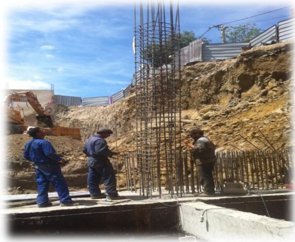
Photo.33. Contrôle de position de ferrailage et recouvrement.
