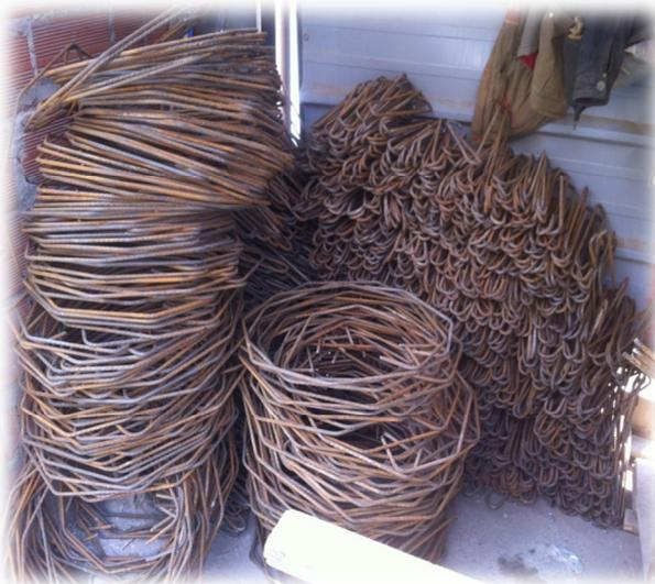
Photo.9. Stockage des cadres et d'épingles façonné
