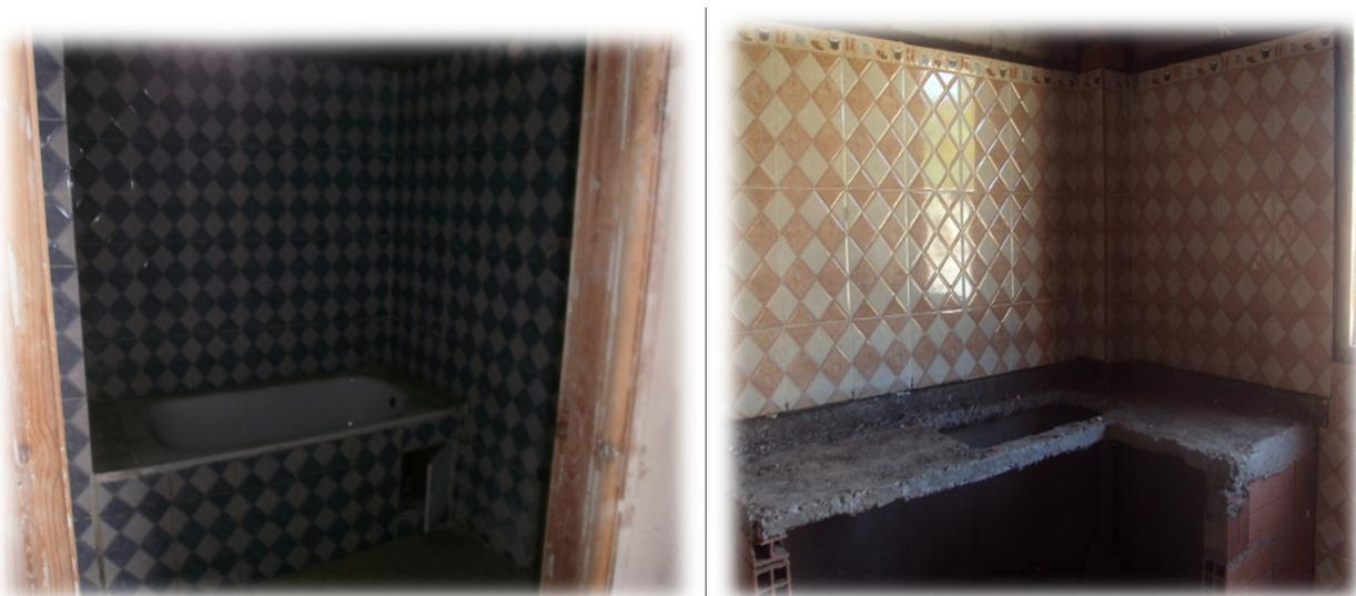
Photo.46. Remplissage des murs de salle de bain et cuisine par céramiques
