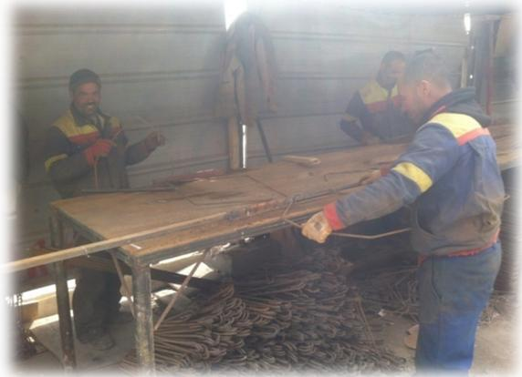
Photo.2. Poste de ferrailage et de façonnage
