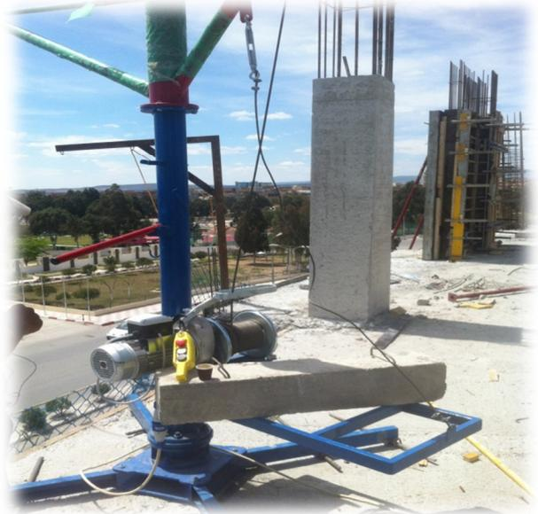
Photo.6. Appareil de levage des matériaux léger
