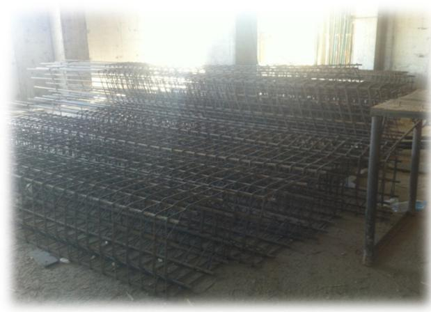
Photo.21. Le ferrailage des poteaux après l'attachement
