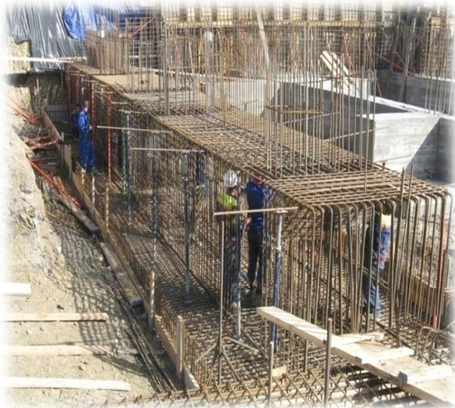
Photo.27. Ferrailage d'une semelle filante.
