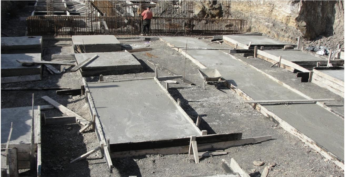
Photo.26. Coulage de gros béton.
