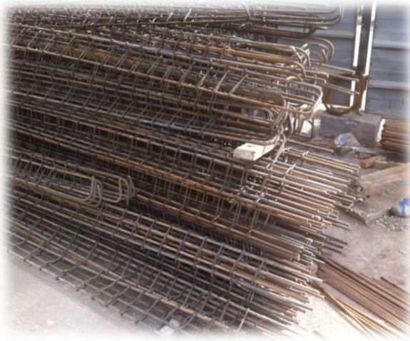
Photo.18. Le ferrailage des poutres.
