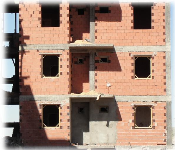
Photo.44. Réalisation des Murs extérieurs
