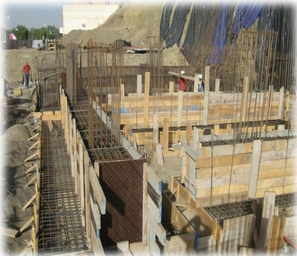
Photo.29. Ferrailage, coffrage des semelles
