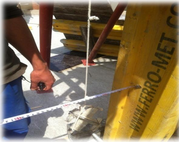
Photo.32. Contrôle de verticalité de poteau
