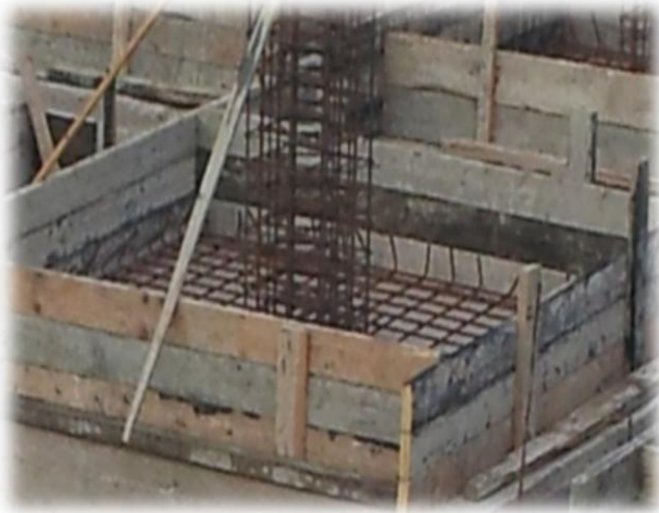
-Coffrage et ferrailage des semelles -
