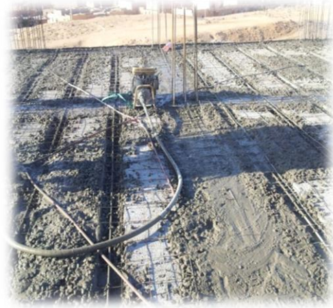
- Coulage du plancher -
