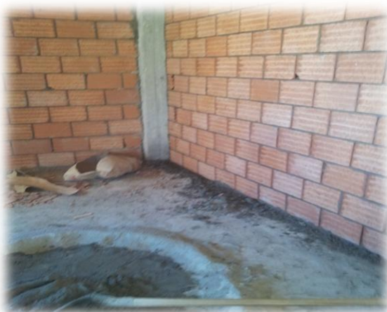
-Les murs en brique creuse-
