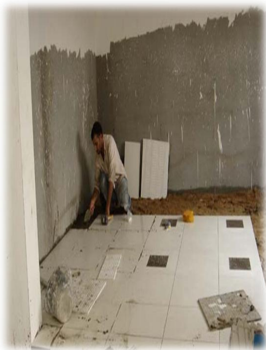
-Revêtement de sol avec les carreaux du granito –
