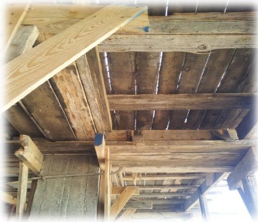
-Coffrage dalle pleine-
