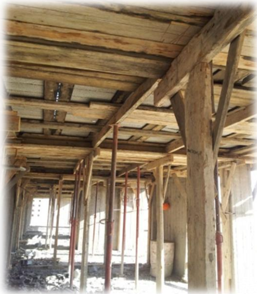
- Coffrage du plancher-
