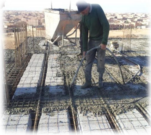
- Coulage du plancher -
