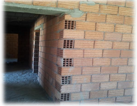
-Les murs en brique creuse-
