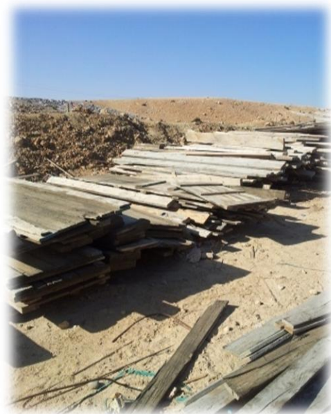
- Le stocke de coffrage –
