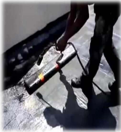
- La réalisation du l'étanchéité-
