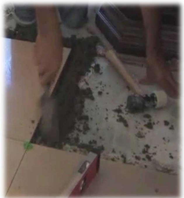
-Revêtement de sol avec les carreaux du granito –
