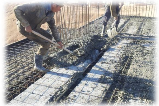
- Coulage du béton-
