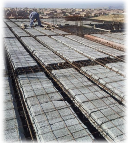
- ferrailage du plancher -
