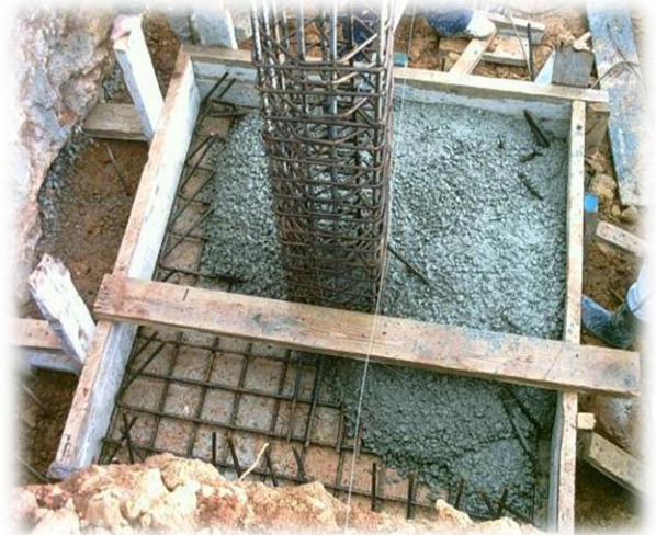
-coulage du béton-
