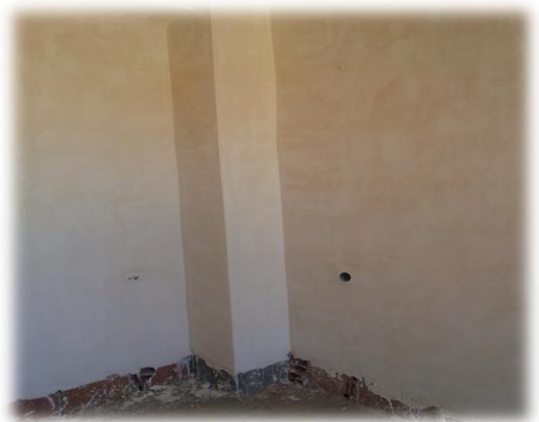
- les murs avec une coche de Platter-
