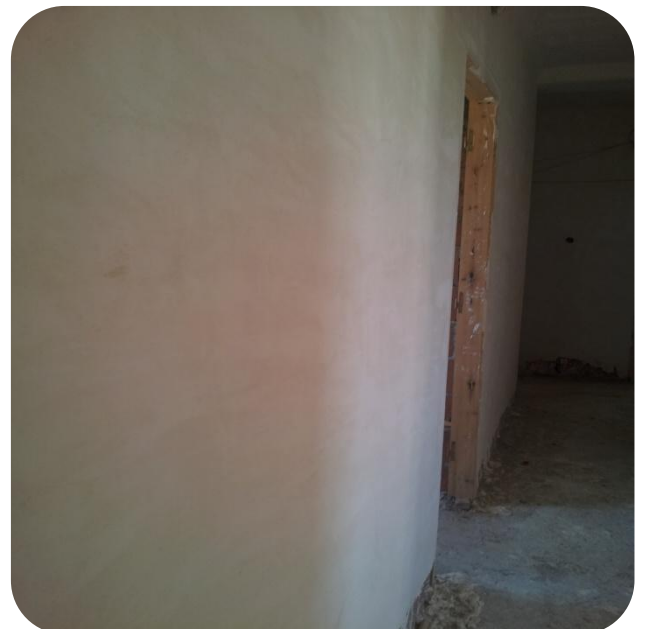
- les murs avec une coche de Platter-
