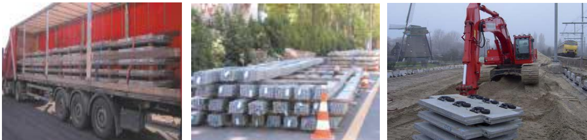
Fig.1 .10. Déchargement et stockage des panneaux.
