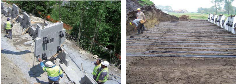
Fig.1 .11. Pose de la première rangée de panneaux et de renforcement.
