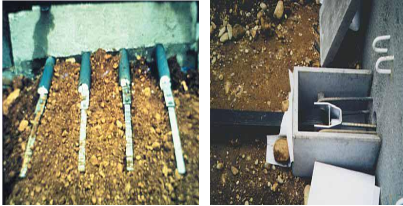
Fig.1 .15. Pose des témoins de durabilité, renforcements métalliques et géosynthétiques.
