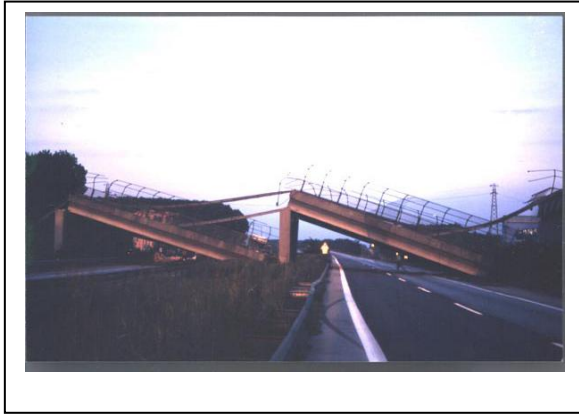
Fig.3.10. Dommages au pont d'Arifiye.
