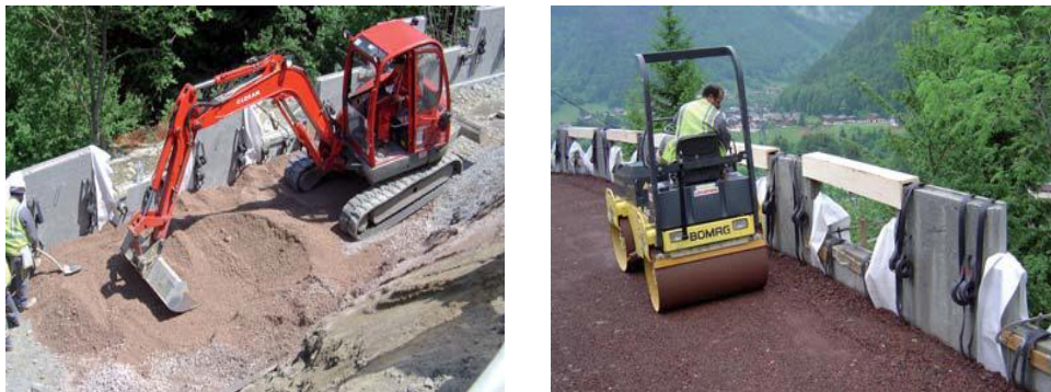
Fig.1 .12. Remblaiement et compactage.
