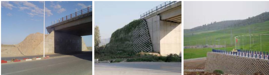
Fig.1 .25. Rampes d'accès de pont réalisées en Algérie.
