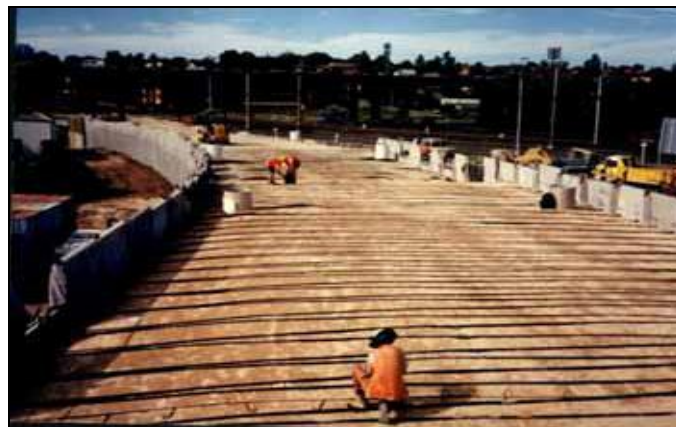
Fig.2.23. Construction d'un remblai d'accès, (S.R.Lo, avant 1997).
