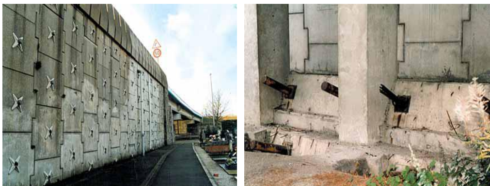
Fig.1 .20. Renforcement par clouage des écailles, ou par des tirants au pied de mur.
