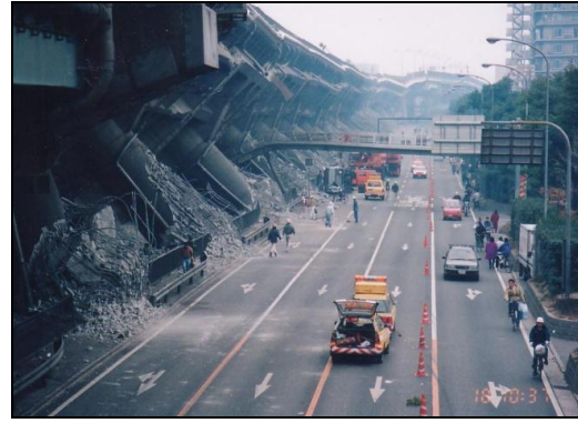
Fig.3.8. Effondrement du viaduc de Fukae.
